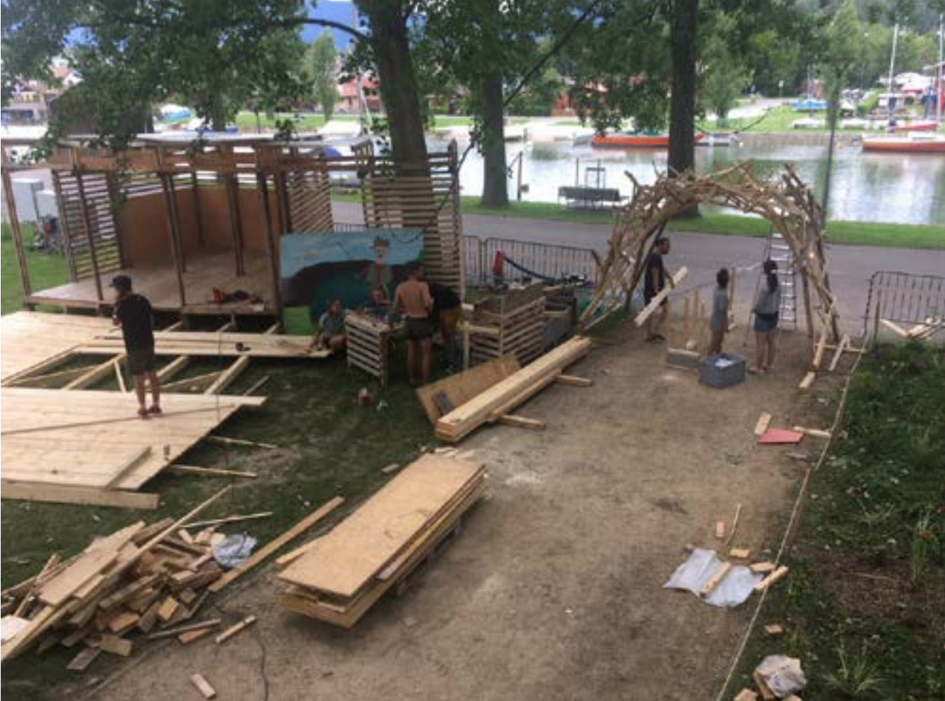
fig.23 Chantier avec participation citoyenne
