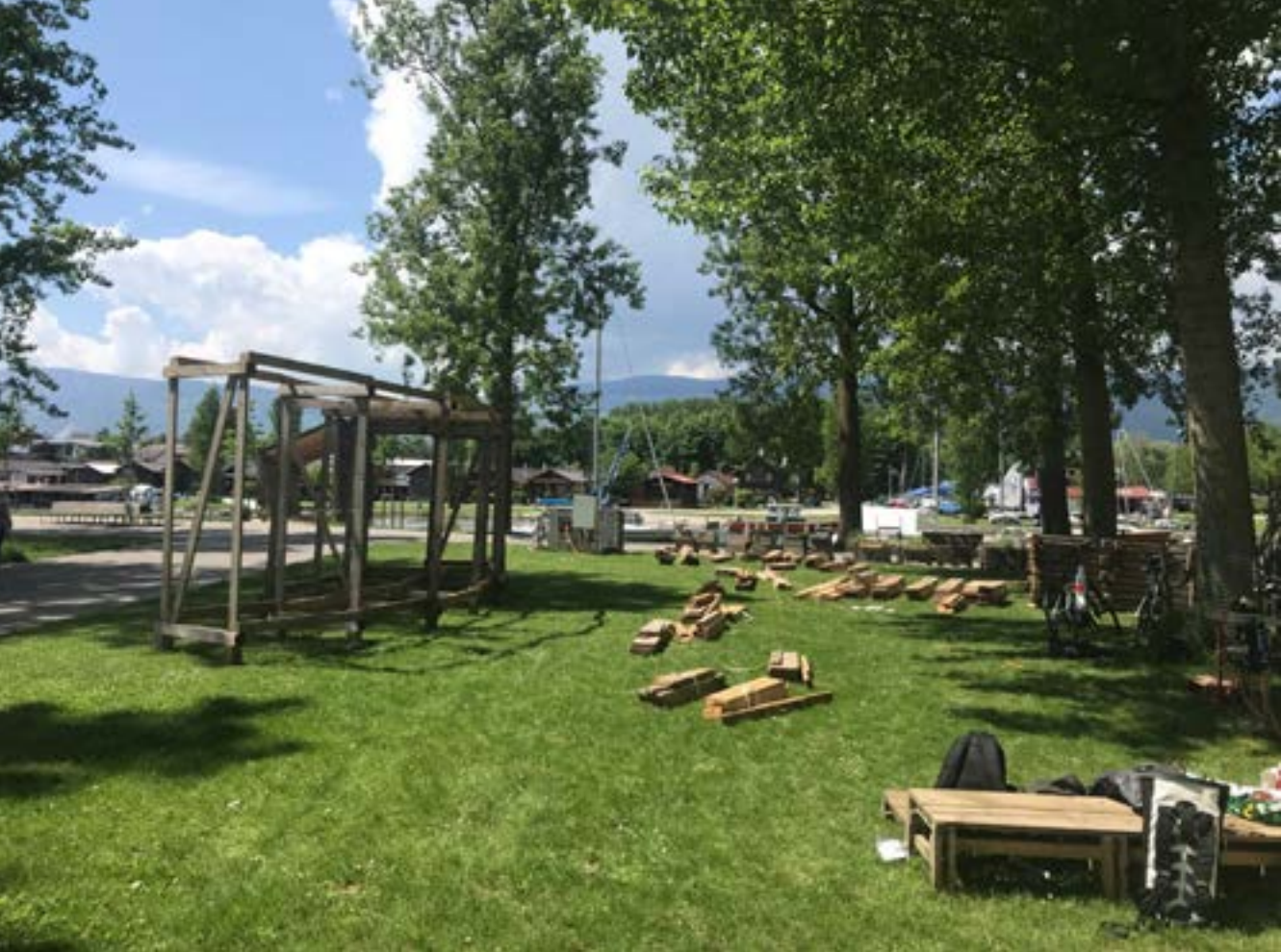
fig. 20 début du chantier
