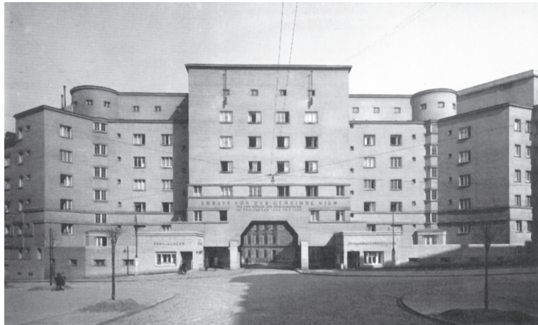
Matteottihof. 1926. H. Schmid et H. Aichinger. Vue de la façade principale. (Blau, 1999)
