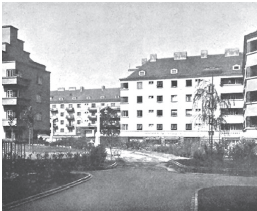
Gauche: Rabenhof. 1925. H. Schmid et H. Aichinger. Vue de la cour intérieure. («Das Rote Wien», 2017)
