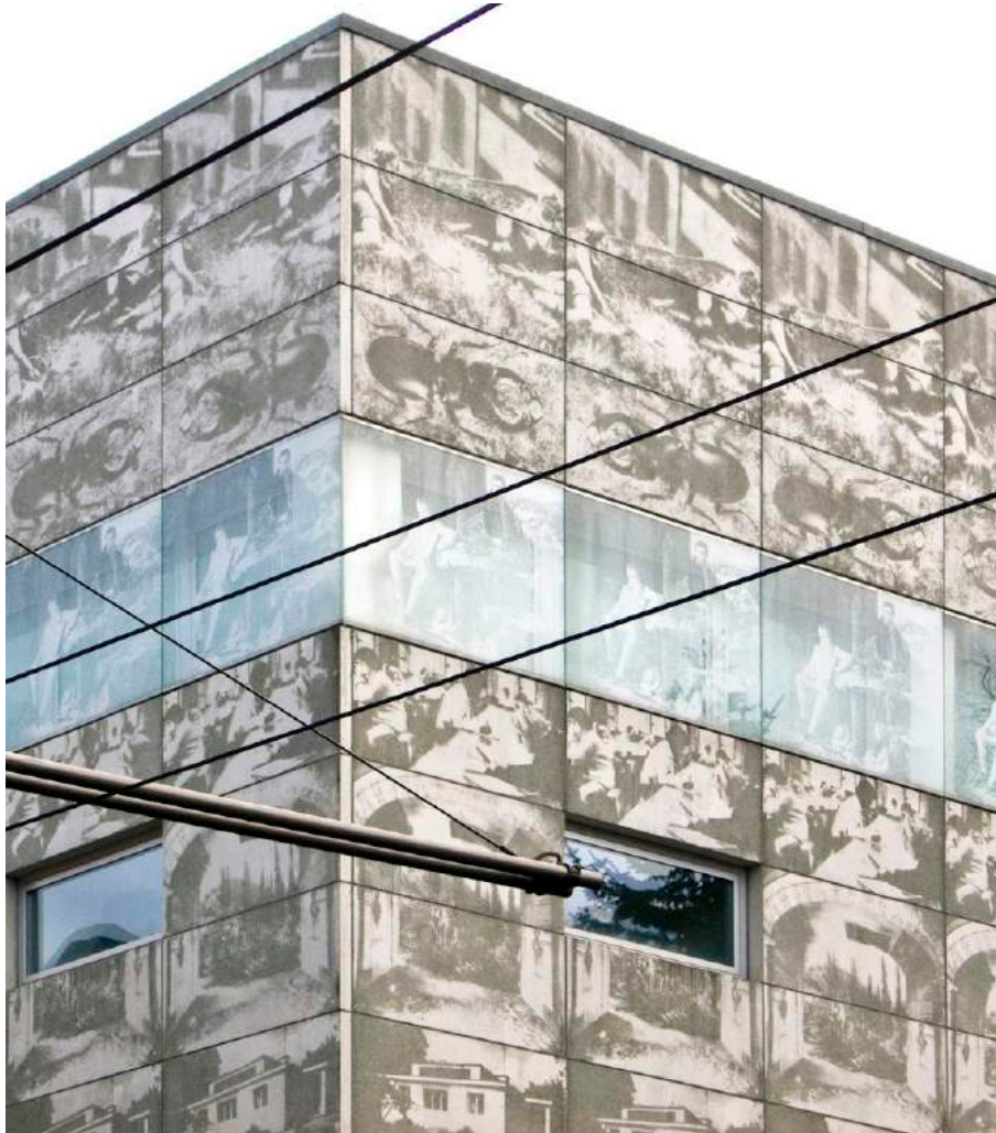
Figure 61, Photographie de la bibliothèque de l'Ecole technique d'Eberswalde construite par Herzog et de Meuron en Allemagne en 1997, © Herzog et de Meuron studio.
