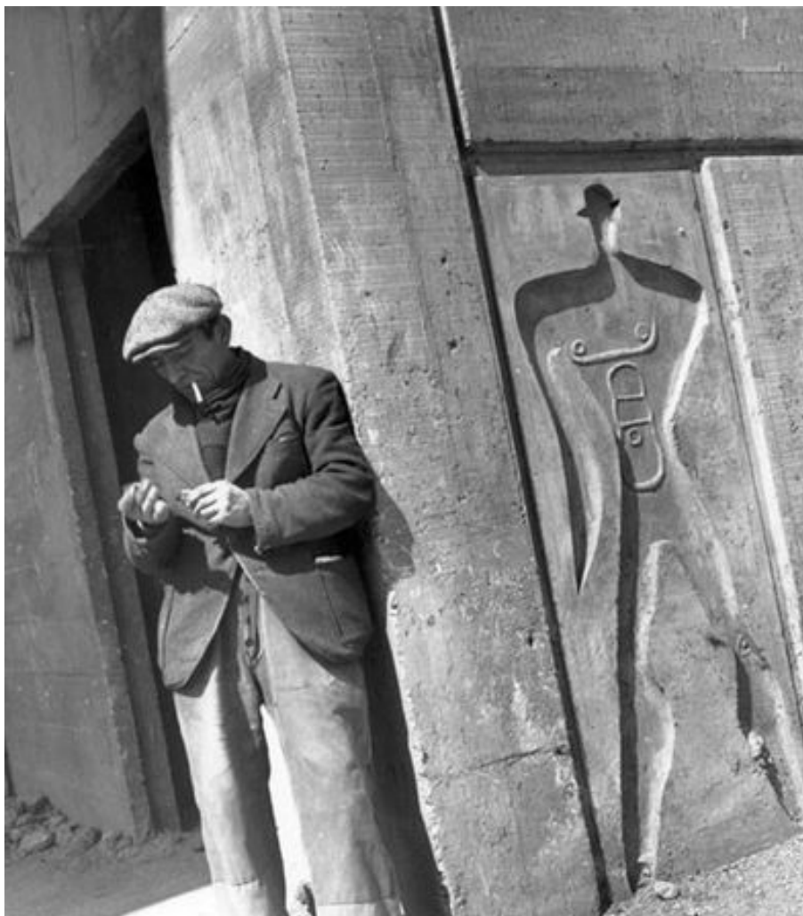
Figure 47, Photographie de l'empreinte du Modulor dans le béton de l'Unité d'habitation de Marseille construite par Le Corbusier en 1947. © FLC, ADAGP, Paris 2015.
