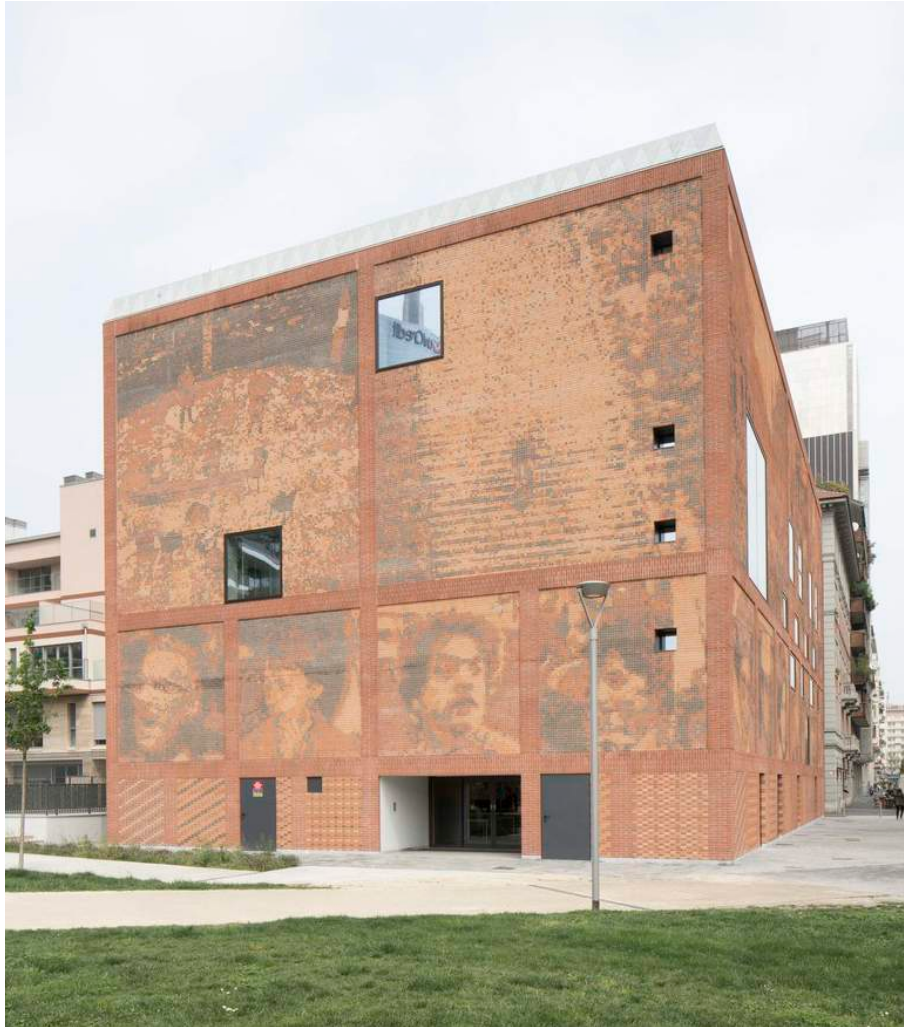
Figure 59, Photographie de la Casa Della Memoria construite par Baukuh à Milan en Italie en 2015. © Stefano Graziani, Giulio Boem.
