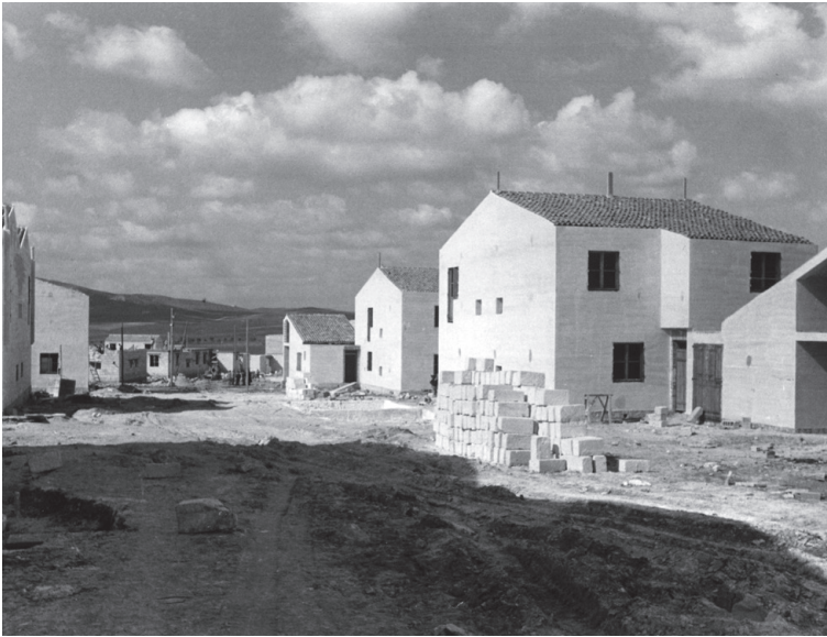
Fig. 61 Construction de la Martella.
