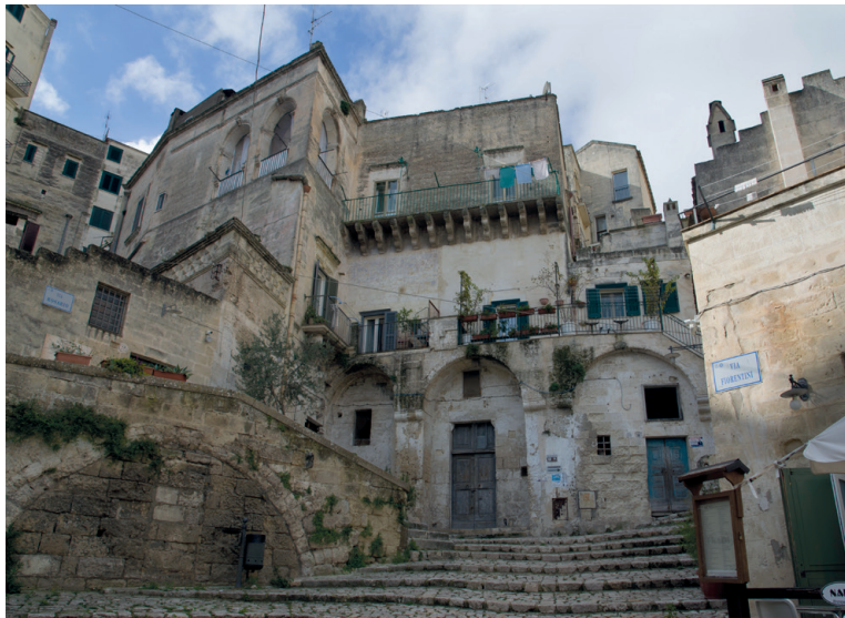
Fig. 47 Maison visitée, façade sur la via Fiorentini.
