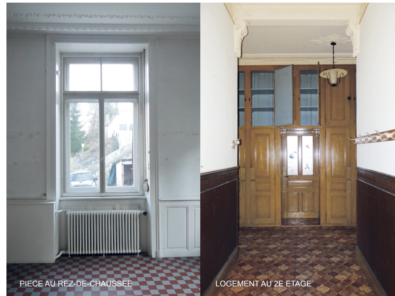
PIÈCE AU REZ-DE-CHAUSSEE
