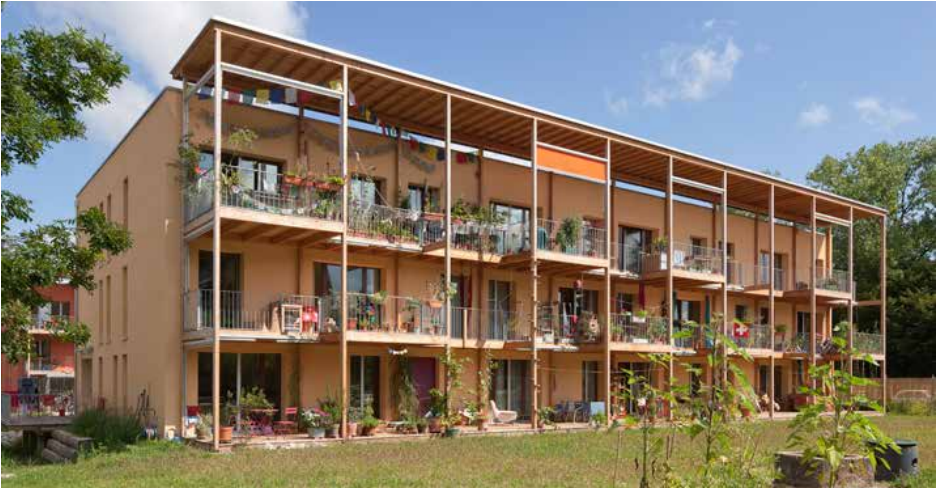
Figure 4.1.3.a Photo de l'ensemble du projet peu après la livraison. Source: Coopérative équilibre
