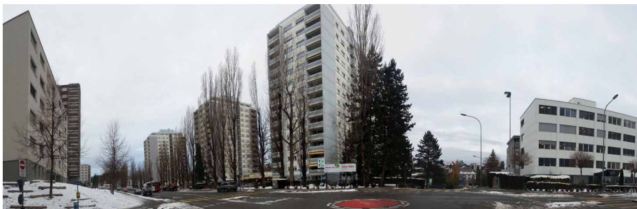
Vue des tours du quartier de Beaumont avec sur la droite la rue descendant vers le site
