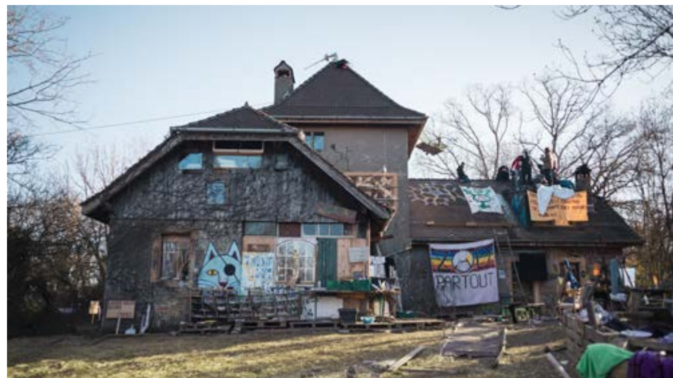
fig. 11 ZAD de la Colline, avant son expulsion, protestant par l'occupation contre la destruction d'un écosystème pour l'exploitation de ciment par Holcim
