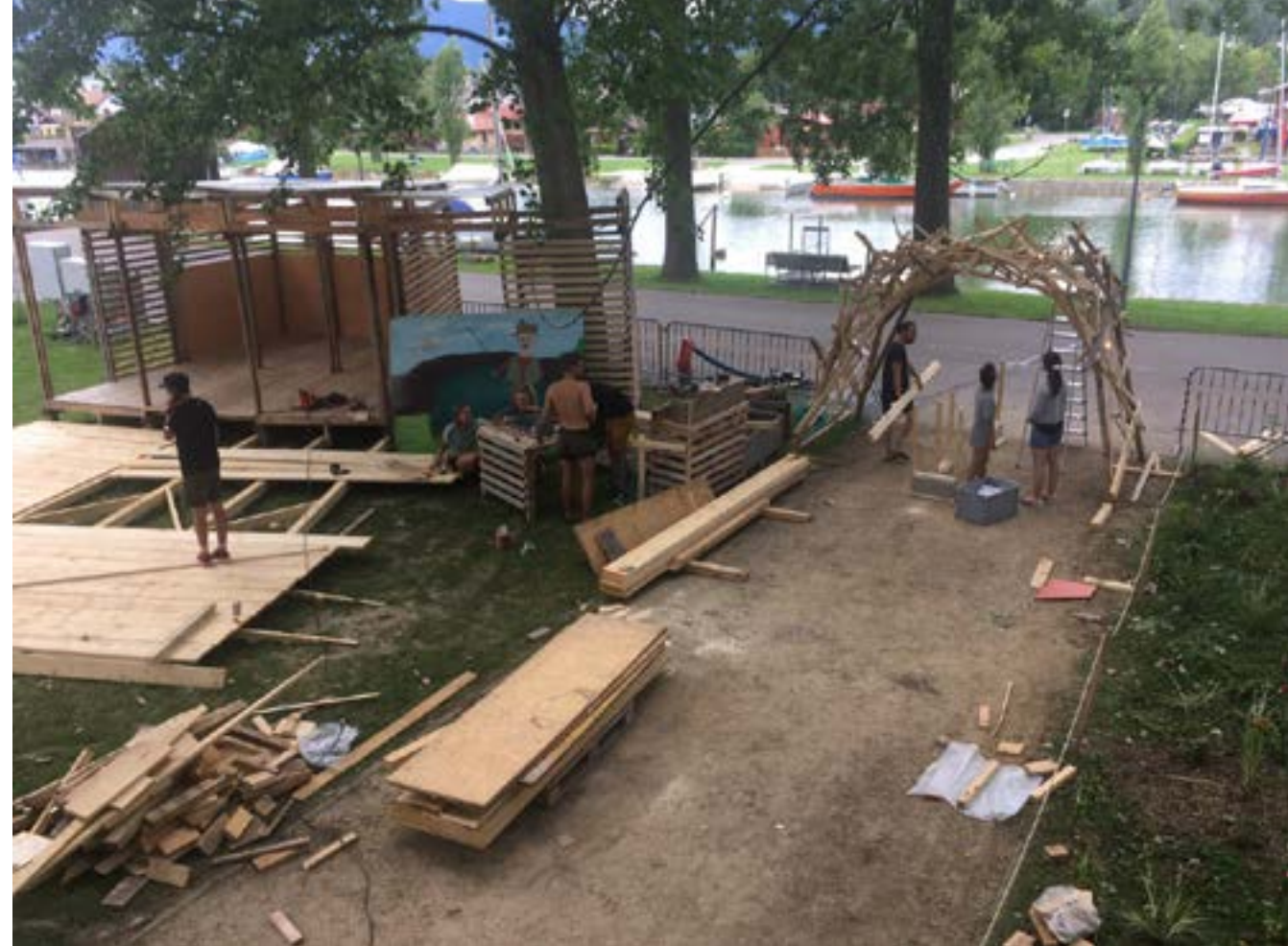
fig. 23 Chantier avec participation citoyenne
