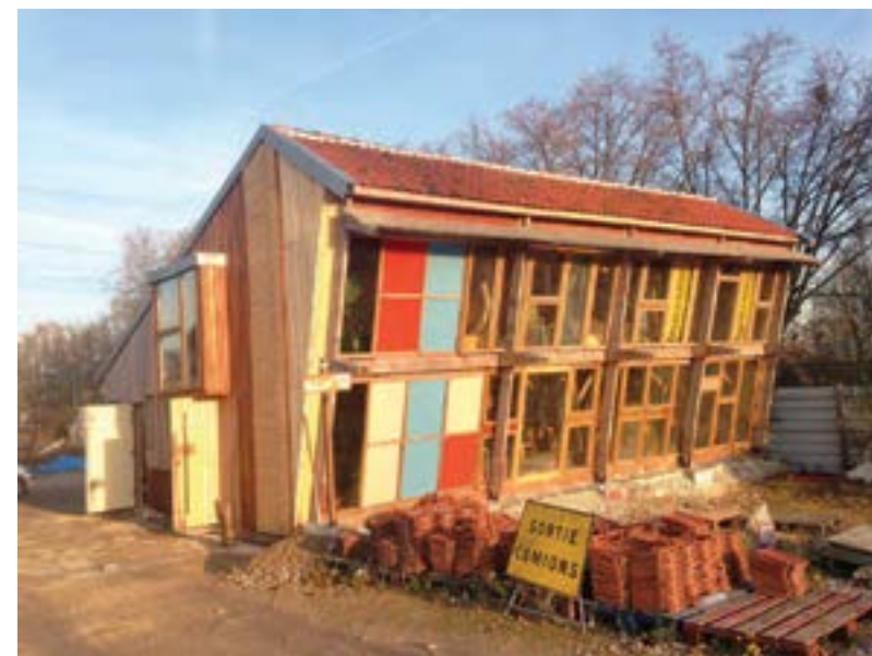
fig. 17 Bureau de chantier d'Actlab, premier laboratoire de Bellastock
