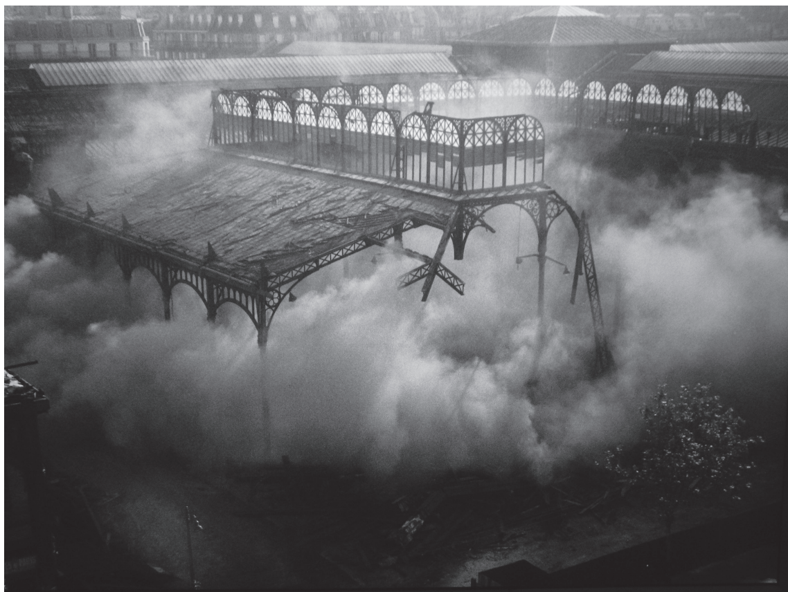
Démolition des Halles de Baltard, Jean-Claude Gautrand, 1971
