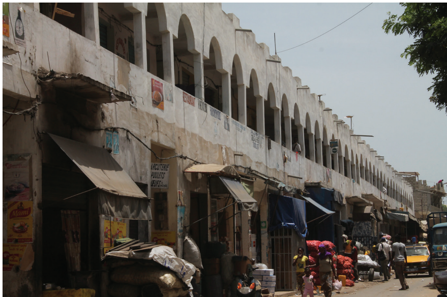
Façade du marché de Nguélaw sur deux niveaux
