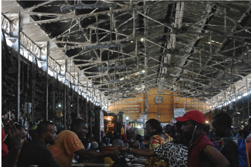
Structure en treillis du marché Tilène
