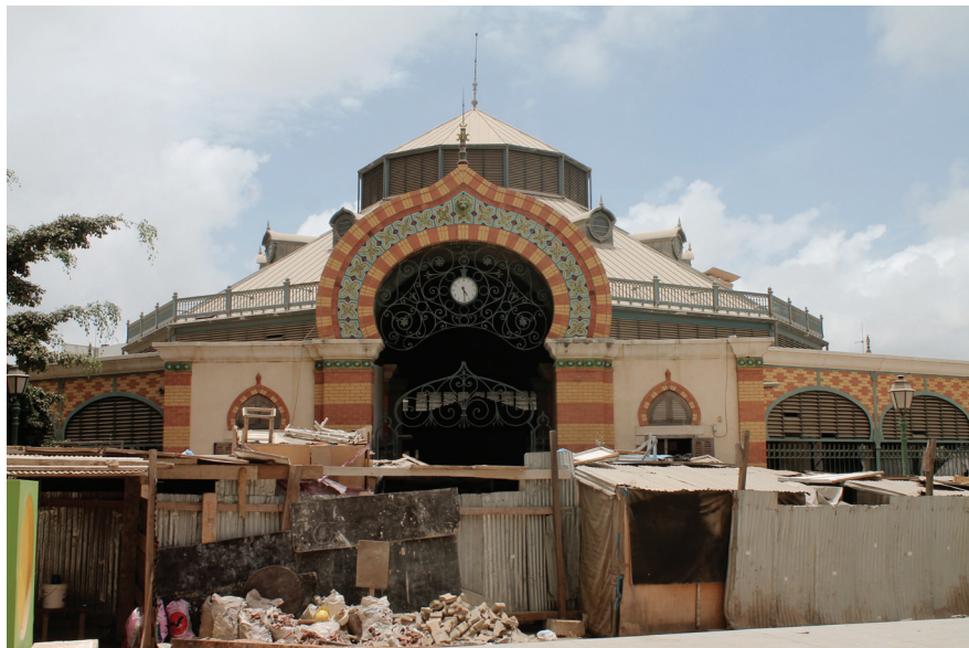
Espaces de vente informels, obstruant les accès au marché Kermel
