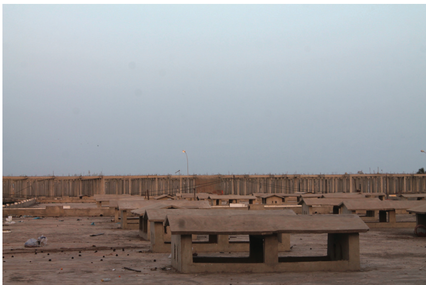
Système de ventilation des blocs de cantines du marché de Thiaroye Gare
