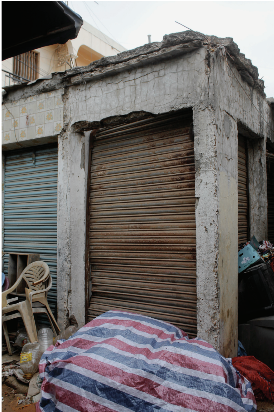
Cantine du marché Police, encombrée par le stockage de marchandises dans le circulations
