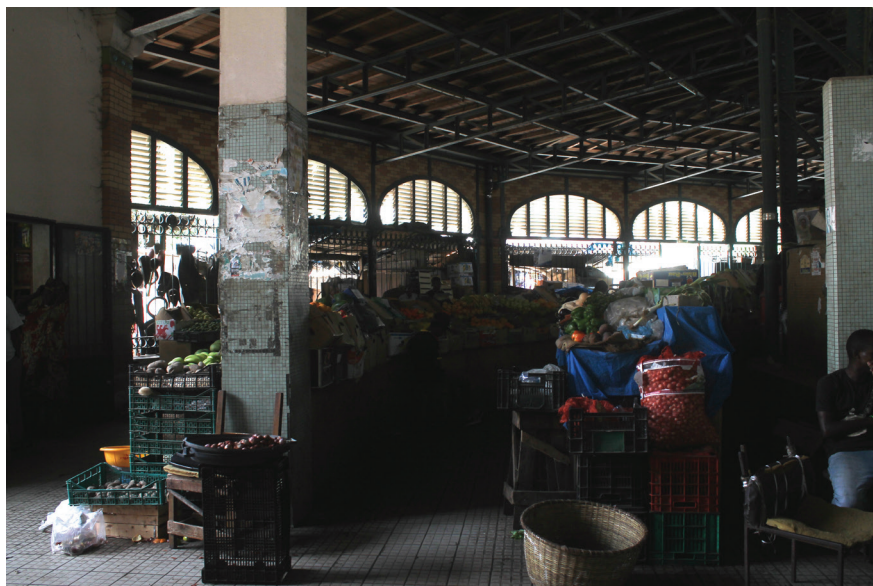
Intérieur du marché Kermel, avec sa structure en treillis métalliques
