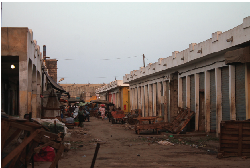
Blocs de cantines du marché de Thiaroye Gare
