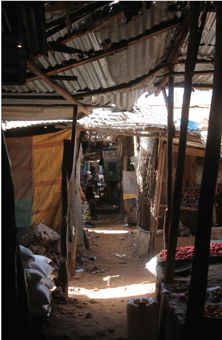
Installation informelles d'espaces de vente en tôle et en bois au marché de Guédiawaye
