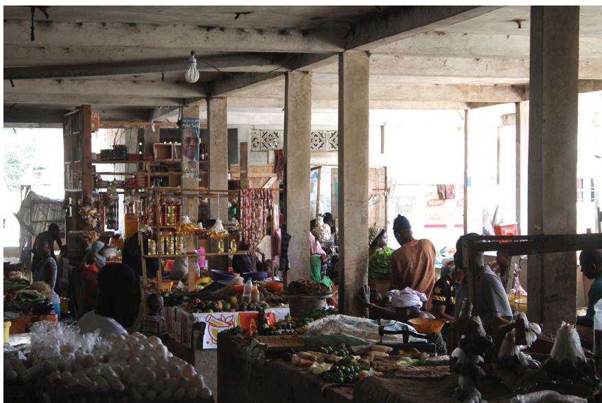
Système poteau-poutre en béton abritant les tables du marché Castor
