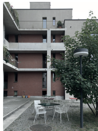
Fig.87 Espace extérieur de l'immeuble à l'avant du bâtiment
