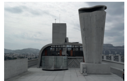
Fig.25 vue de la toiture-terrasse depuis le théâtre
