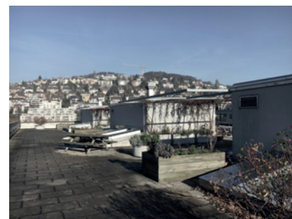
Fig.40 toiture-terrasse en hiver
