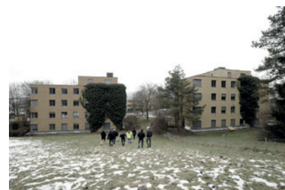
Fig. 74 vue des bâtiments avant transformation - depuis l'arrière © Kraftwerk1
