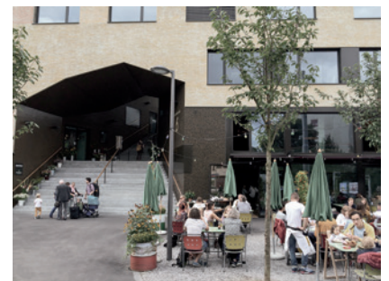
Fig. 101 vue de l'escalier d'accès à la cour
