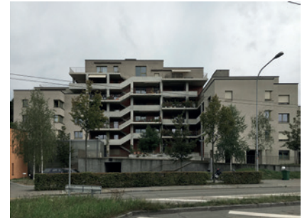
Fig.80 vue du bâtiment après transformation depuis la rue
