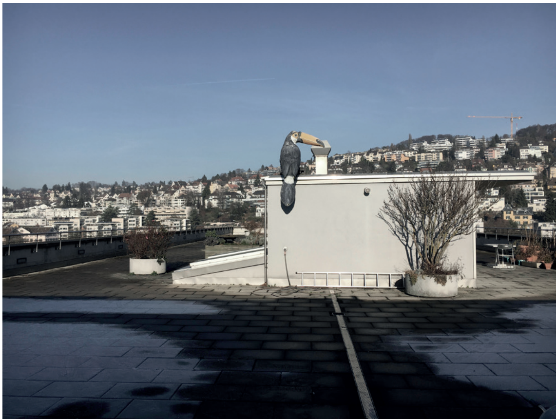
Fig.51 toiture-terrasse en hiver
