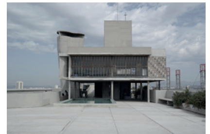
Fig.24 vue de la toiture-terrasse : le solarium
