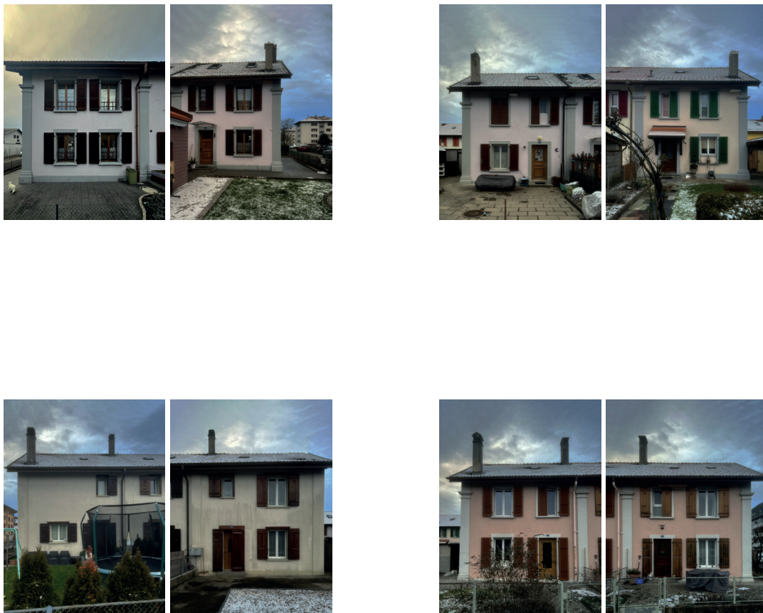
Fig 10: Façades des 10 maisons ouvrières à Broc, aujourd'hui
