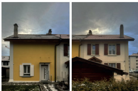
Fig 9: Façades des 10 maisons ouvrières à Broc, aujourd'hui
