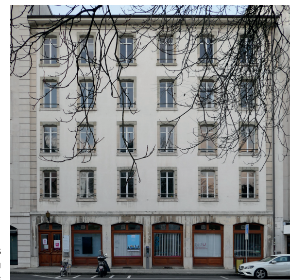
L'hôtel de nos jours. Les balcons et la marquise au rez ont disparus depuis
