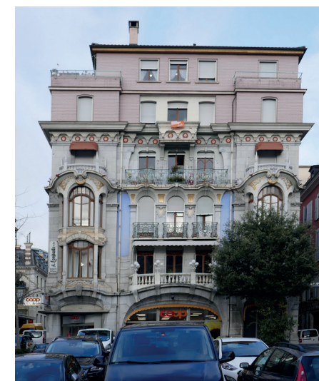
Le même bâtiment, après la surélévation de deux niveaux et la suppression de la toiture d'origine en 1957 par W.Baumann
