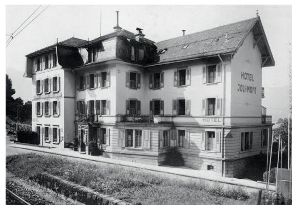
Hôtel Joli-Mont, Montreux. Photo prise depuis les rails du chemin de fer reliant Montreux à Zweisimmen. Le corps de bâtiment le plus à gauche est le fruit d'un aggrandissement en 1912
