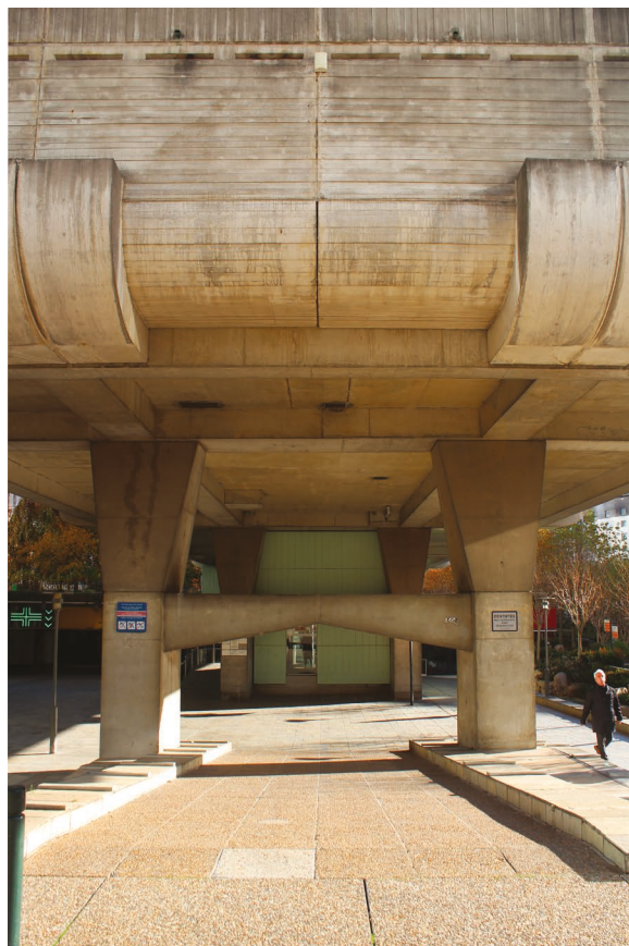
fig 18. Structure des pilotis en rez-de-chaussée
