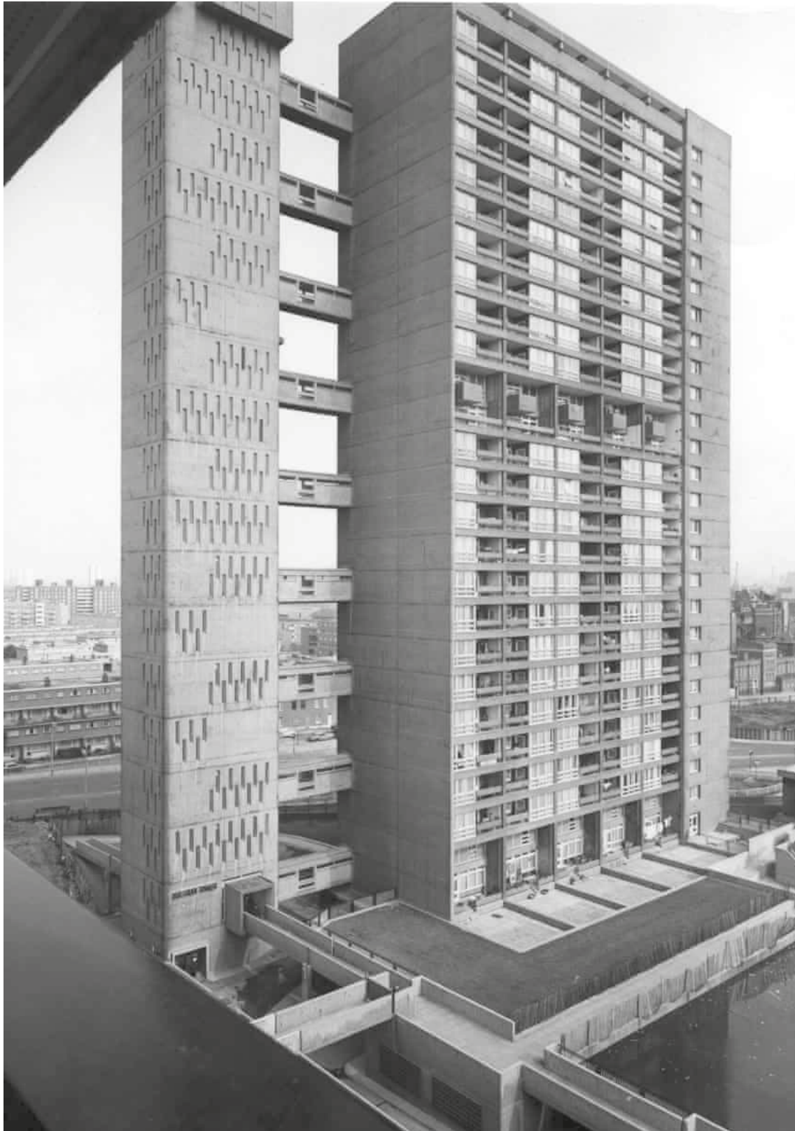
fig 27. Vue extérieure de la Balfour tower lors de sa construction
