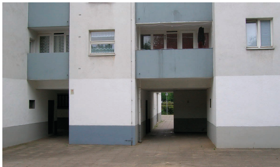
fig 25. Passage couverts au rez-de-chaussée avant rénovation
