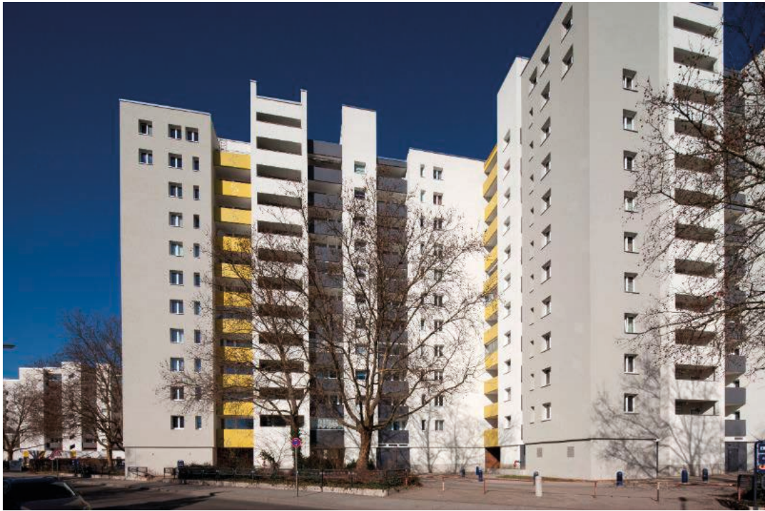
fig 25. Vue extérieure depuis le parking après rénovation
