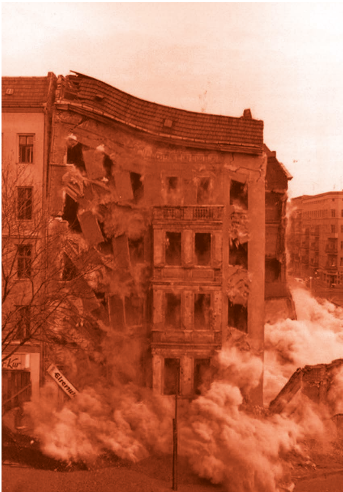
fig 11. Démolition de Mietkaserne à Berlin en 1963.
