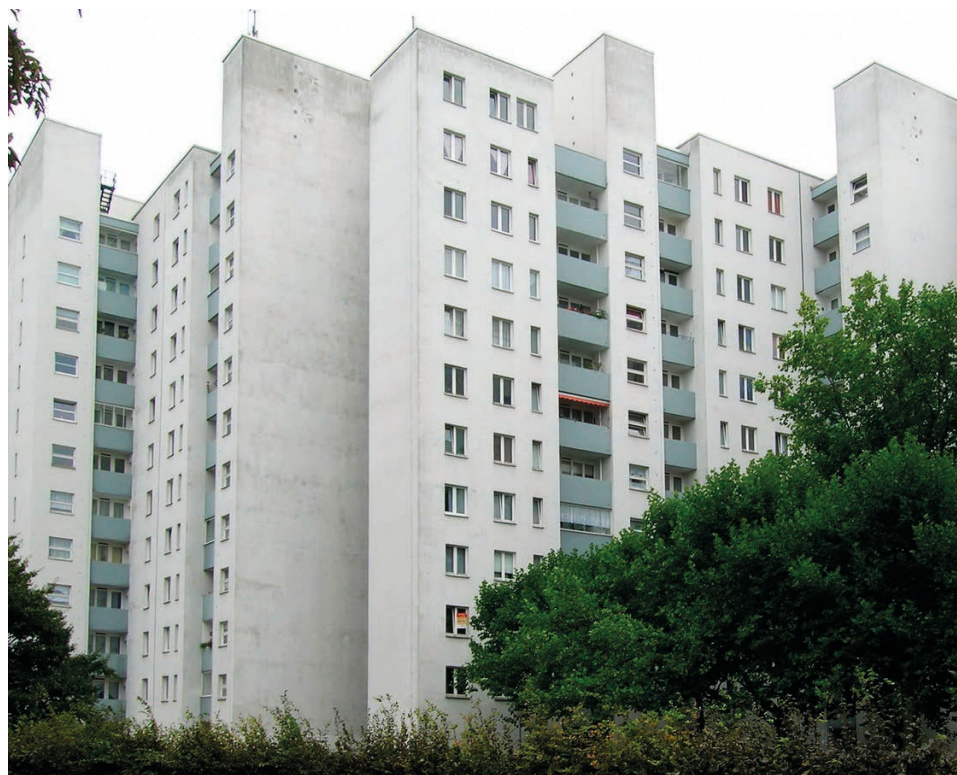
fig 38. Vue extérieure depuis le parking avant rénovation
