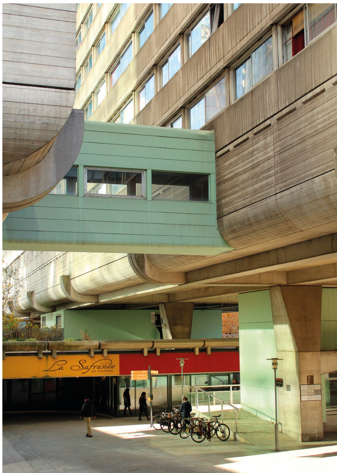
fig 15. Vision 80, commerce en rez-de-chaussée
