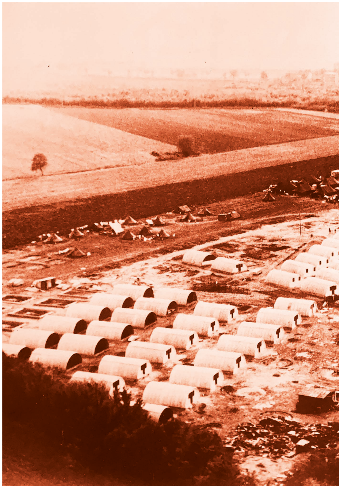
fig 3. Installation des « igloos » par l'abbé Pierre dans une cité d'urgence à Noisy-le-Grand en mai 1954.
