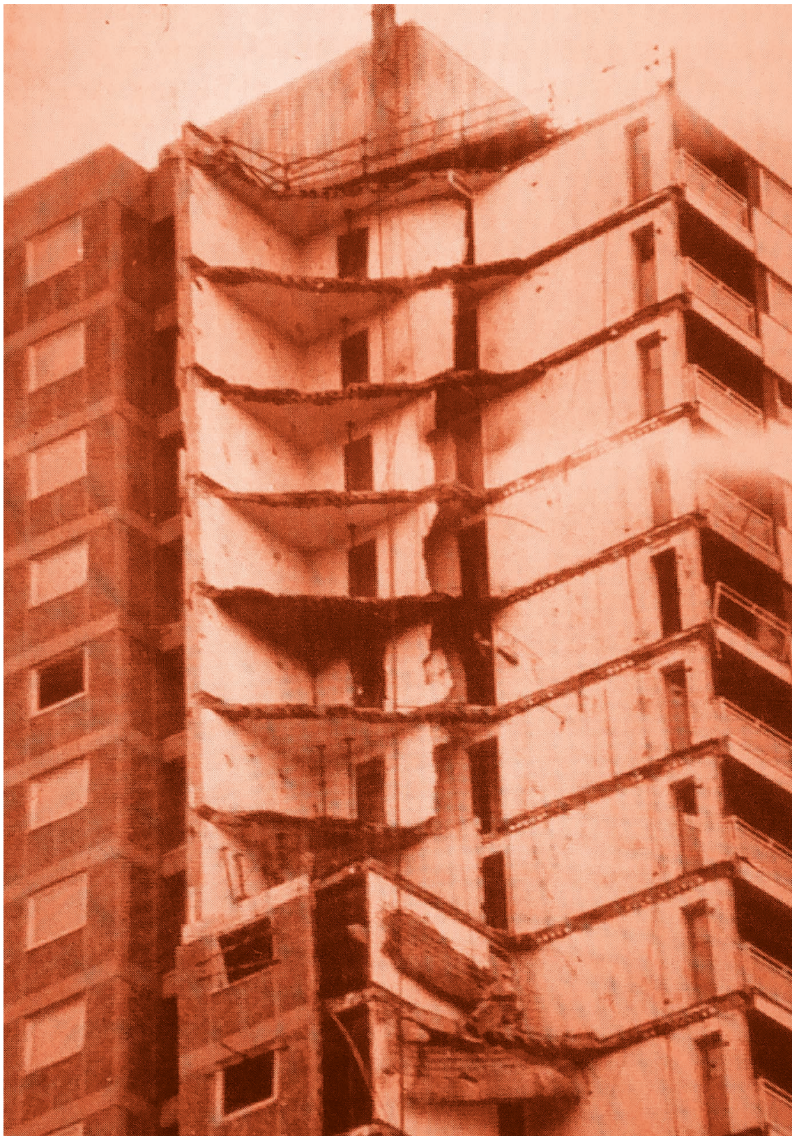
fig 7. Desastre de Ronan Point en 1968, photographie par Ernö Goldfinger.
