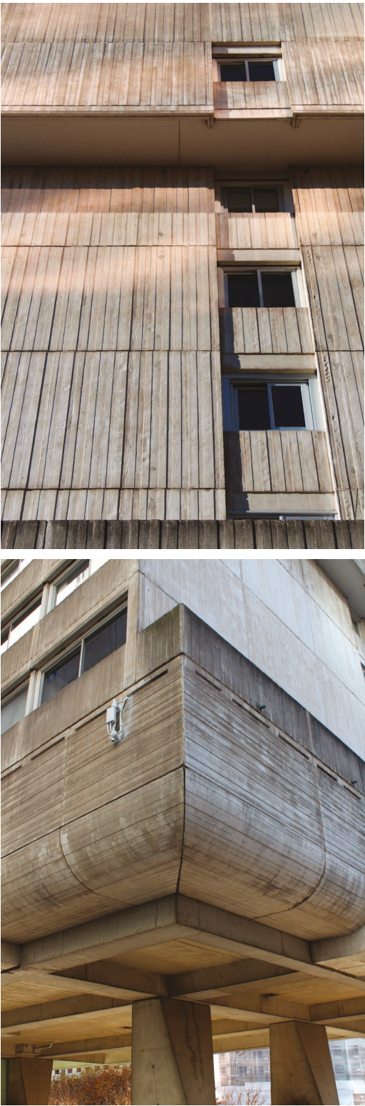
fig 21. Détails de coffrage
