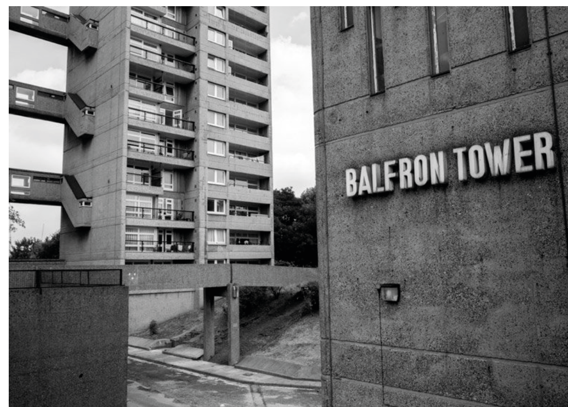
fig 29. Entrée du bâtiment
