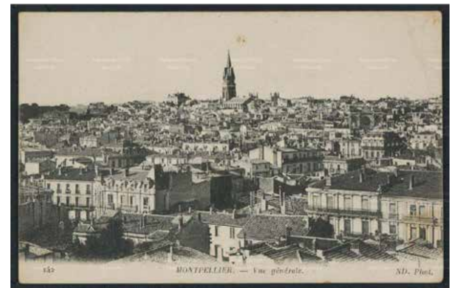
Fig 2. Montpellier - vue sur la ville - entre 1910 et 1930
