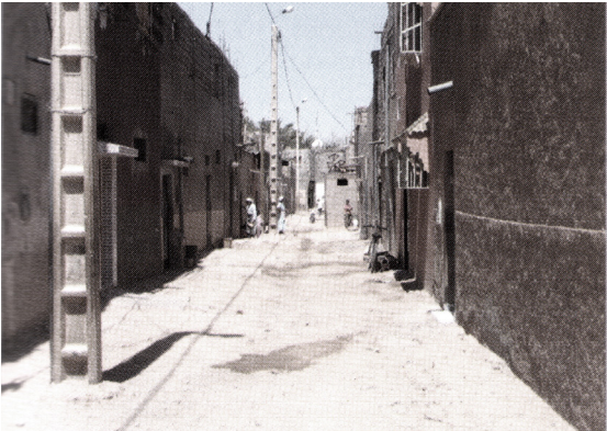
Restructuration AL HAOUZ
