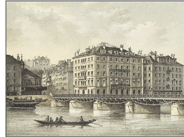
FIG. 23: Pont des Berges aux alentours des années 1850
