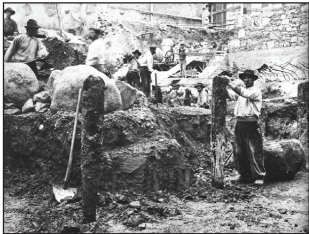
△ FIG. 8: Bloc ératique et pilotis d'une ancienne digue. fouille de 1910
