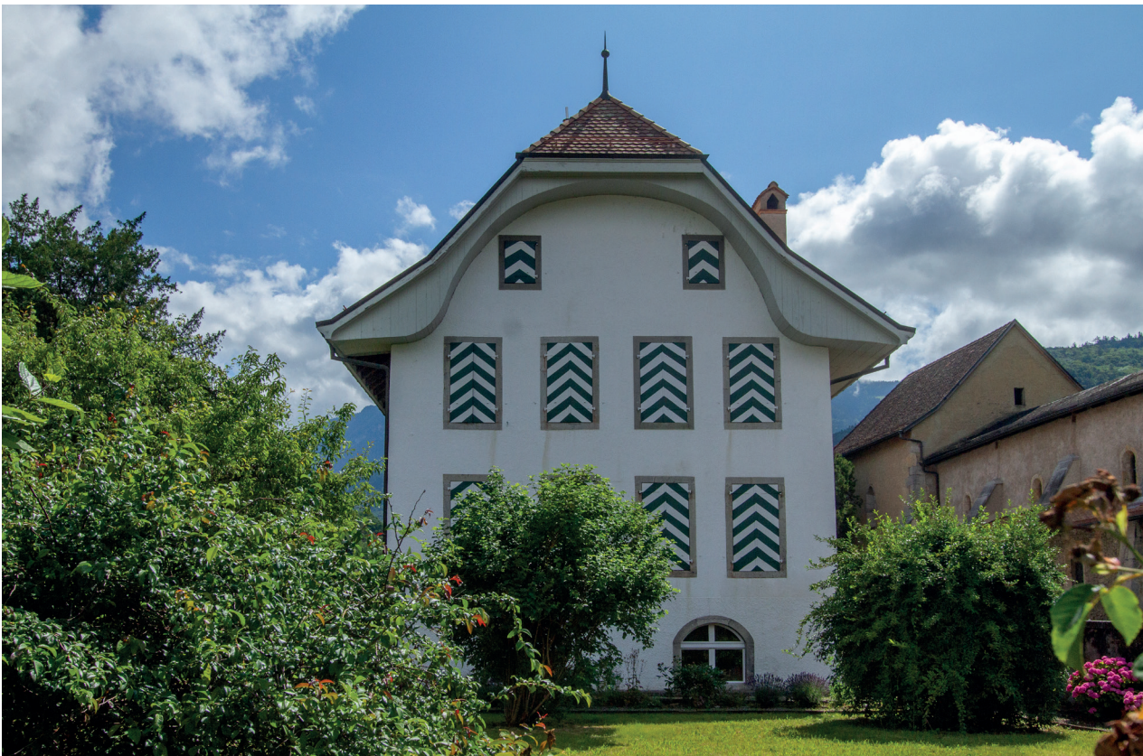
façade principale ouest
