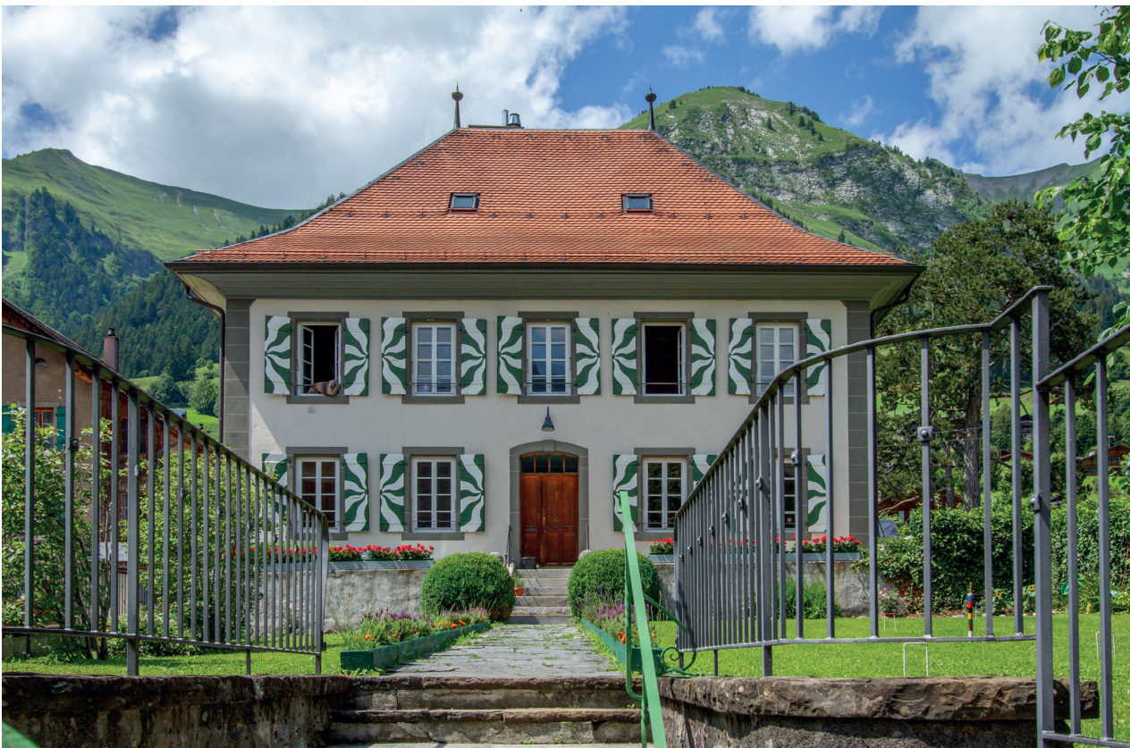
façade principale sud-ouest
