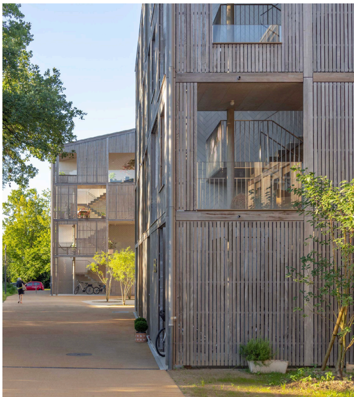
façade sur cour
