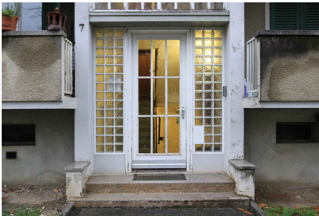
entrée au numéro 7 du chemin des Hutins
