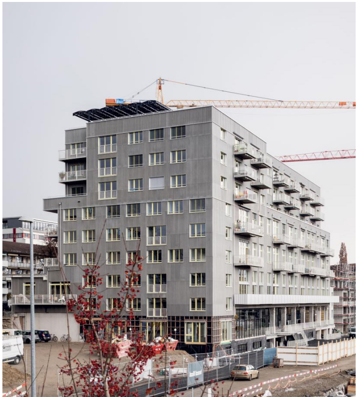
façades nord et sud-est
