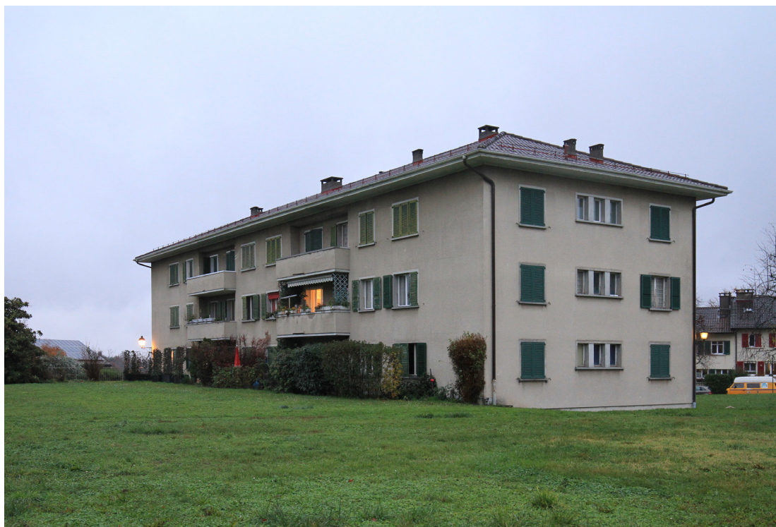
façade nord et pignon ouest
