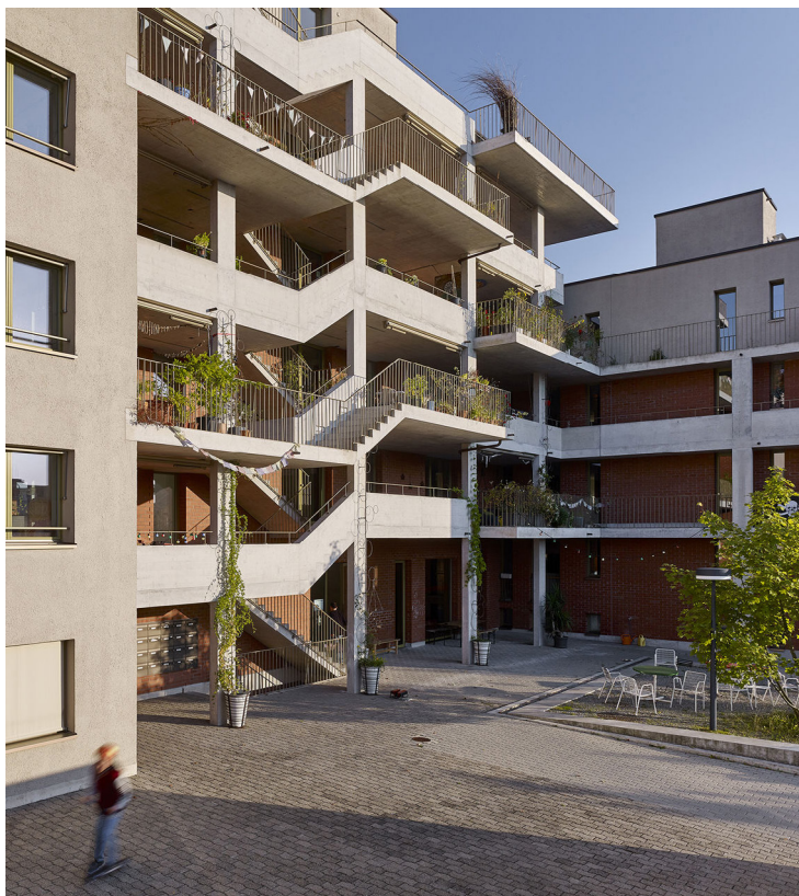
façade sur cour
