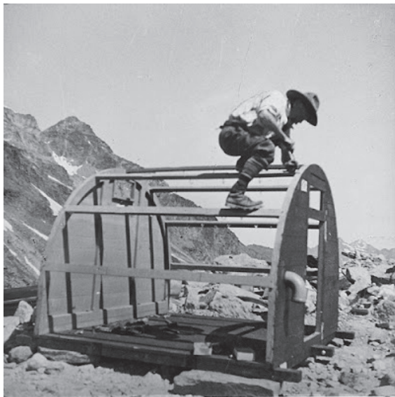
Figure 3. Refuge en demi-cylindre, 1925, Lorenzo Borelli
