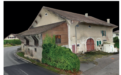
Photogrammétrie par drone - Le phénomène d'occlusion sous la toiture est important © 3D Swiss View SàRL 3D Swiss View [reproduit avec l'aimable autorisation de l'auteur]
