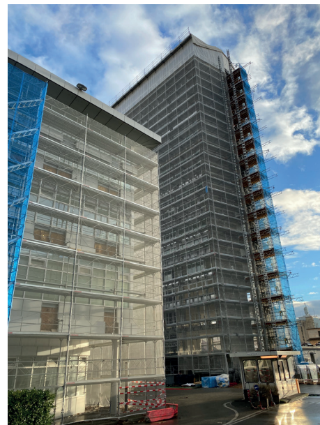
Chantier du PAV pointe Nord à Genève ©Julien Porret
