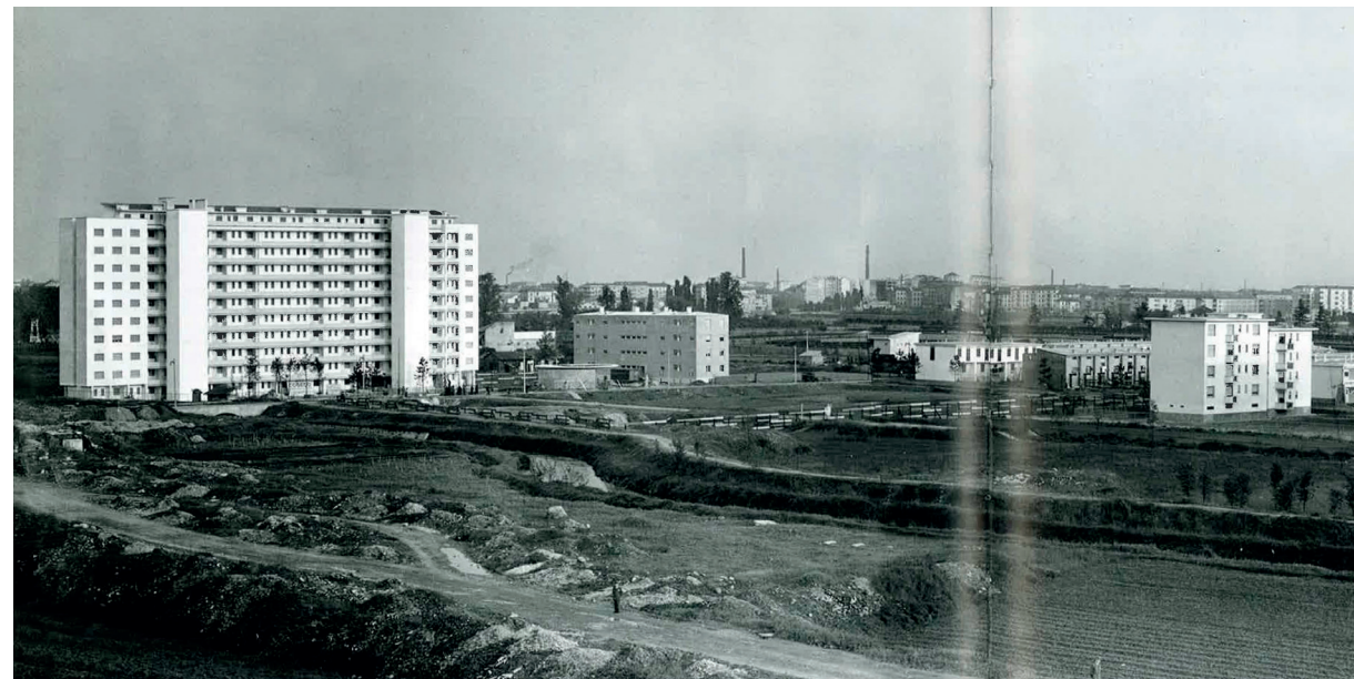
Immeuble Ina-Casa à onze étages pendant le chantier, été 1951.
