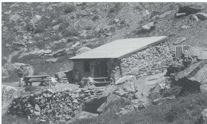
27. Refuge de montagne érigée sur une palettoforme en pierre empilée
