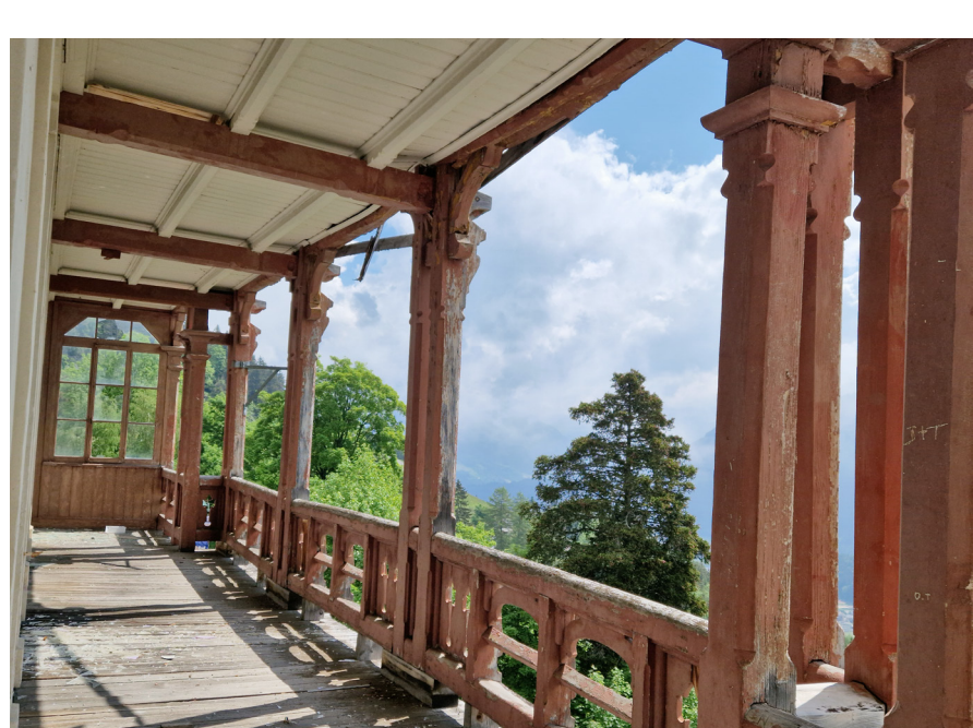
photos de l'état du bâtiment (2023)
