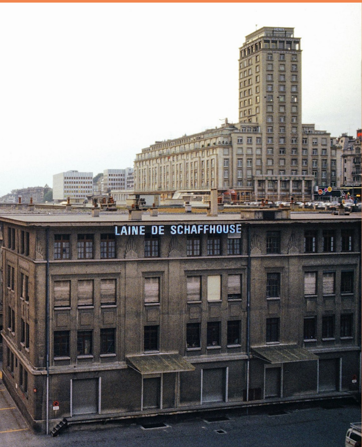
Le Quartier du Flon face à la Voie du Chariot, 1980
