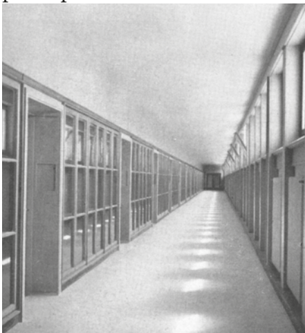
Fig 55: Vue de meubles d'origine dans les couloirs
