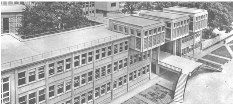
Fig 13: Bâtiment de Cours
