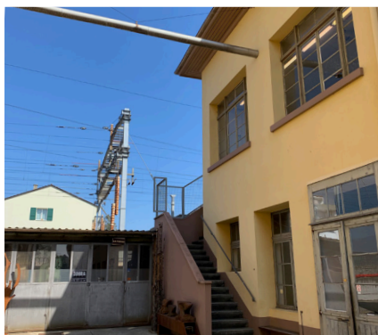
Fin du bâtiment proche des CFF et Bât 13
