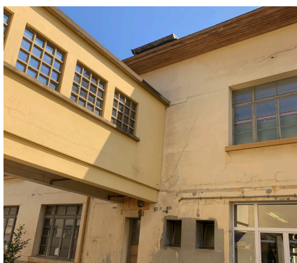
Passerelle communicante entre Bât 5 et 8
