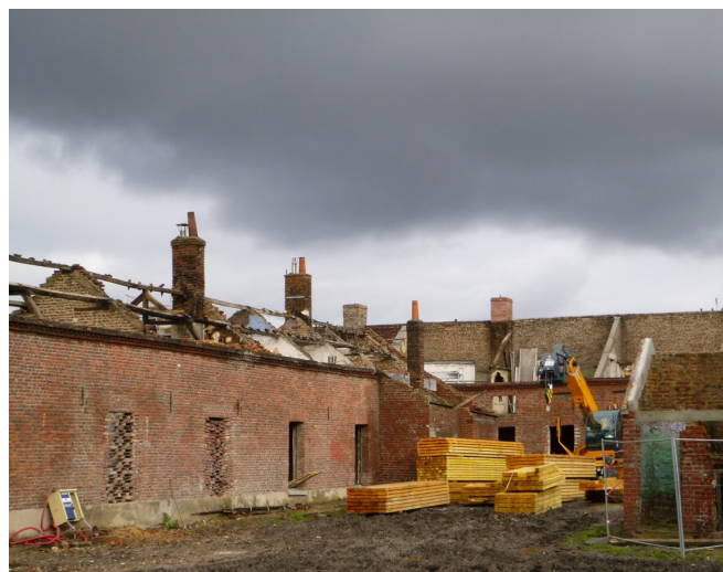
La Cité des Électriciens, Travaux de réhabilitation
