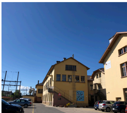
Vue bâtiment 6 depuis l'entrée
