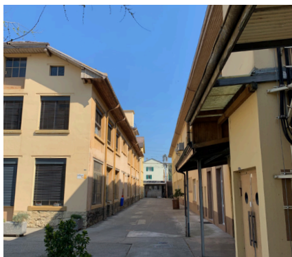
Vue depuis la cour, passage entre Bât 3 et 5
