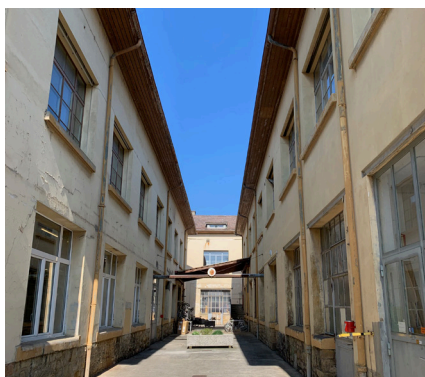
Bât 5 et 4 vers Bât 6
