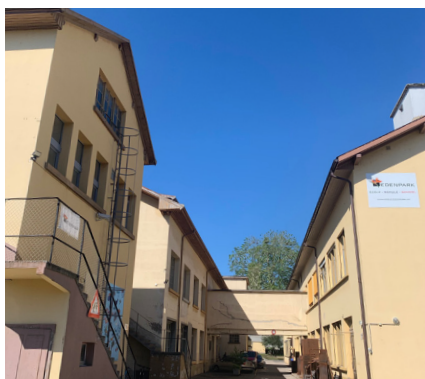
Vue bâtiment 6 vers Bât 5 et 8
