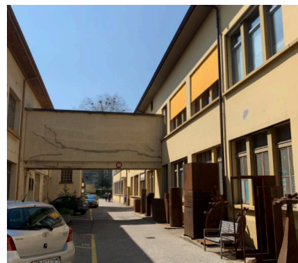
Passerelle entre Bât 5 et 8
