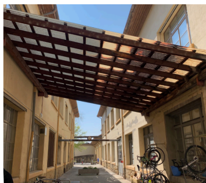
Bât 4 et 5 vers la cour intérieur
