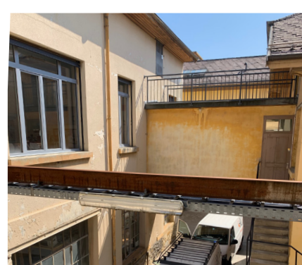
Passerelles vers Bât 6
