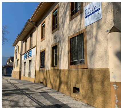
Bâtiment 1 construit en plusieurs phases
