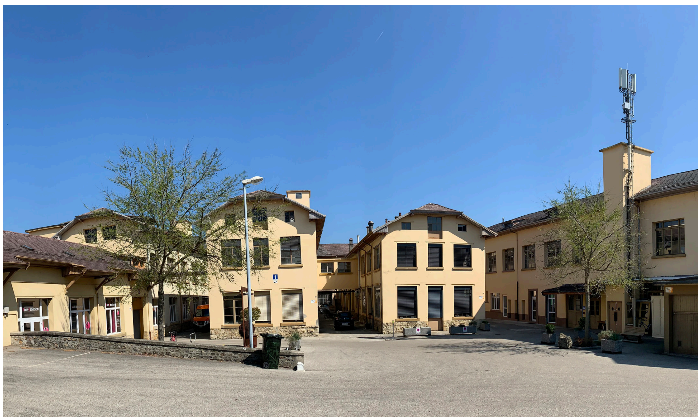
Ancienne Usine Leclanché , vue des Bât 2, 3, 4 et 5 depuis la cour intérieure
