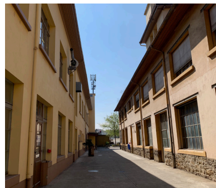
large passage entre Bât 3 et 5
