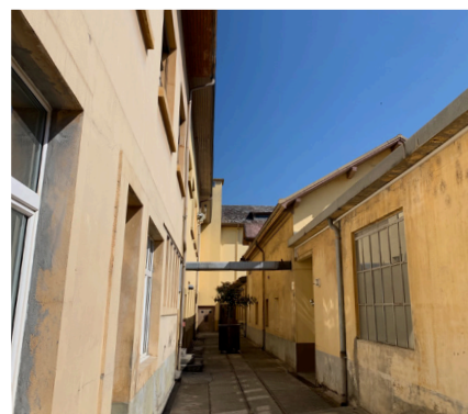
Passage vue intérieur entre Bât 1 et 2
