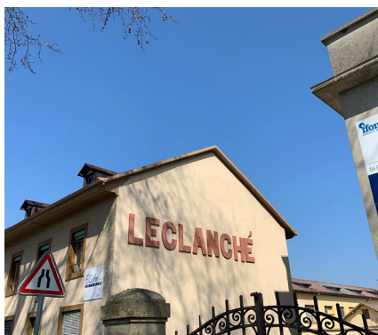
Facade donnant sur la route principale
