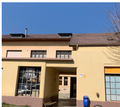
Long bâtiment constitué d'un rez avec passage vers les Bât 2 et 12
