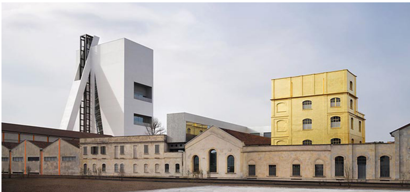
Vue d'ensemble externe de la Fondation Prada
