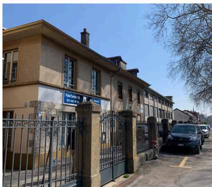
Bâtiment 1, ancien portail
