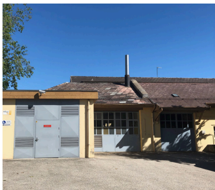
Garages depuis la cour intérieure
