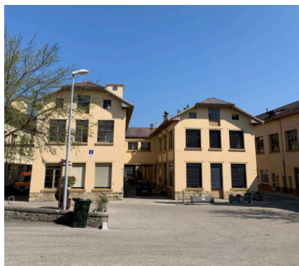
Cour intérieur Bât 4 et 3
