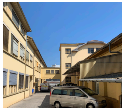
Vers les CFF, large ruelle entre Bât 5 et 8
