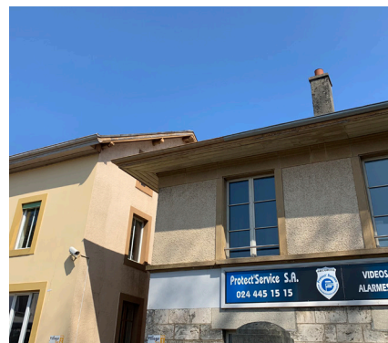
Toitures bâtiment 1 et 2, très rapprochées
