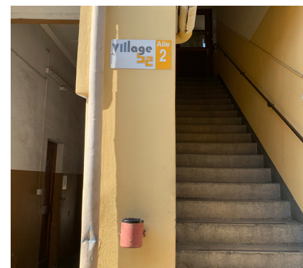
Escalier externe qui mène au 1er étage
