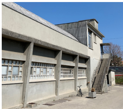
Façade nord ouest
