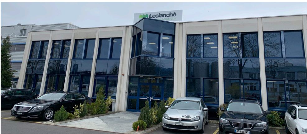
Leclanché Lithium GmbH, nouveau bâtiment
