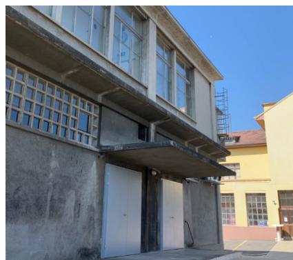
Façade nord est, vers Bât 1
