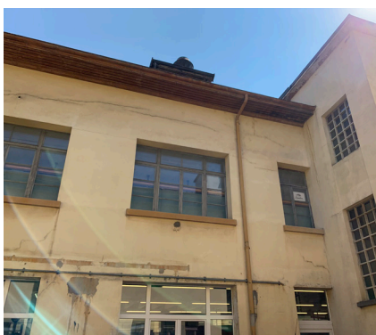
Fenêtres d'origine au 1er et nouvelles au rez
