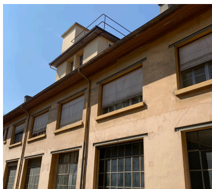
Façades d'origine, bâtiment désaffecté
