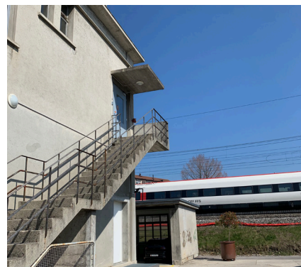
Façade nord ouest, vers voies des CFF
