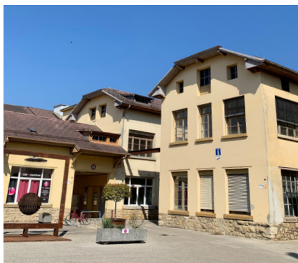
Vue Bât 4 depuis la cour intérieur
