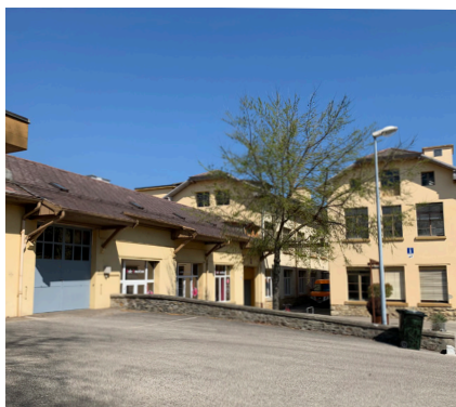
Passerelle communicante entre Bât 1 et 2
