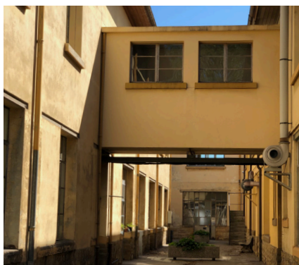
Passerelle communicante entre Bât 1 et 2
