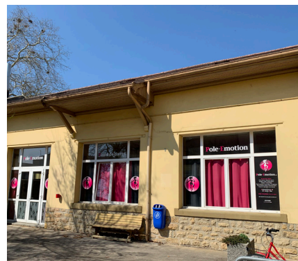
École de danse, partie basse du bâtiment 5
