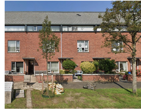
5.6. Différences d'aménagements des accès Photographie : Google maps
