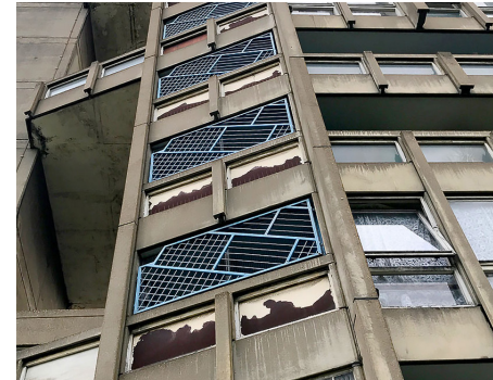
3.6. Vue sur les colonnes de distribution verticales Photographie : greyscale.com
