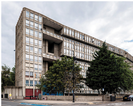
3.4. Extrémité d'une des deux barres Photographie : © Iñigo Bujedo-Aguirre - source : architecturalrecord.com
