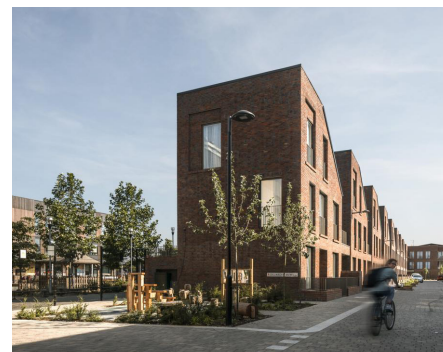
7.6. Extrémité nord de l'ensemble
