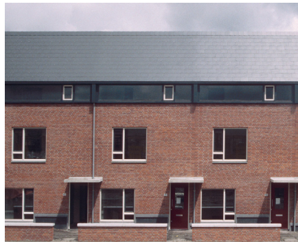
5.5. La régularité typologique visible en façade Photographie : Hans Van Der Heijden Architecten
