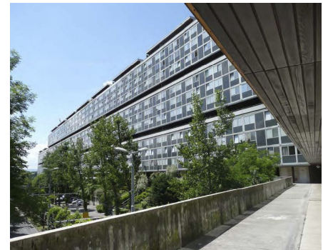
2.6. Vue depuis une coursive de distribution Source : Patzrick Wicht, Des logements de qualité à loyers abordables dans les grands ensembles
