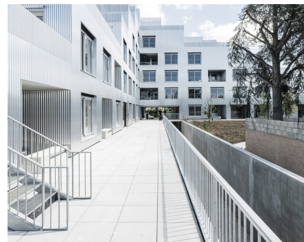
8.6. Allée d'accès ouest vue vers l'entrée principale
