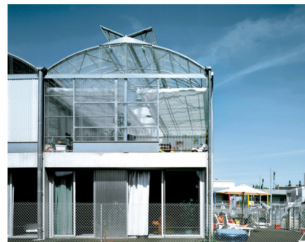
6.6. Vue depuis le Sud sur un logement et sa terrasse
