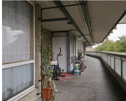
3.2. Courseive desservant l'ensemble des logements de l'étage Photographie : http://kvadratinterwoven.com © Photo Anthony Palmer
