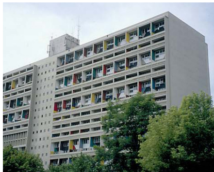
1.5. Vue générale du bâtiment et ses loggias colorées Photographie : Sbriglio et Le Corbusier, Le Corbusier: l'unité d'habitation de Marseille . © Archives Fondation LeCorbusier
