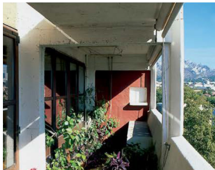
1.2. Espaces extérieurs privatifs en simple hauteur Photographie : Sbriglio et Le Corbusier, Le Corbusier: l'unité d'habitation de Marseille . © Archives Fondation LeCorbusier
