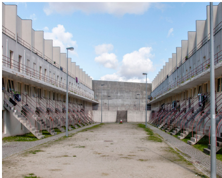
4.4. Espace collectif central, accès au projet Photographie : Dezeen.com
