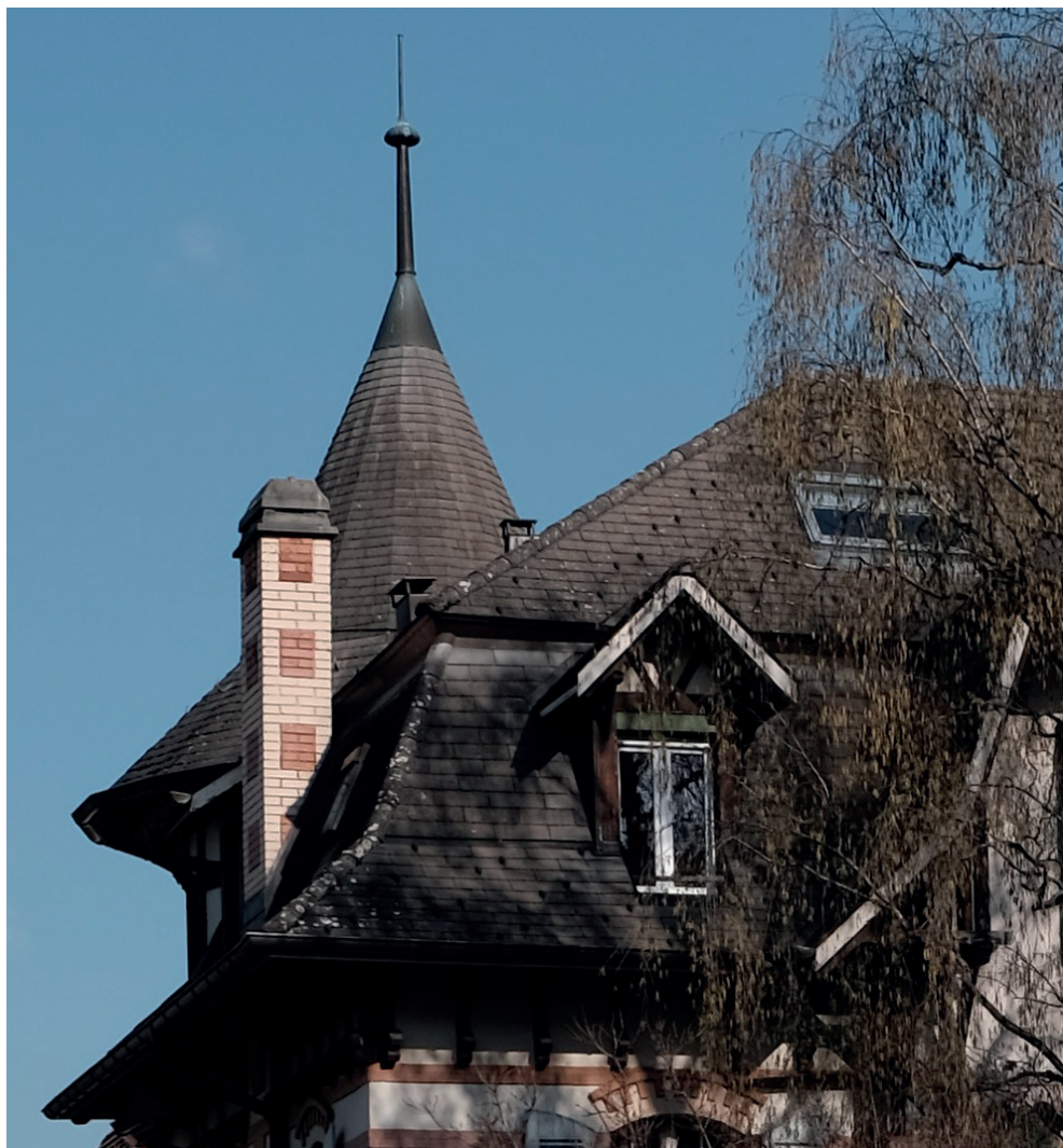
Figure 31 : Toiture de la Maison, Rue du Haut-Fourneau 7, Delémont. Photo de l'auteure.
