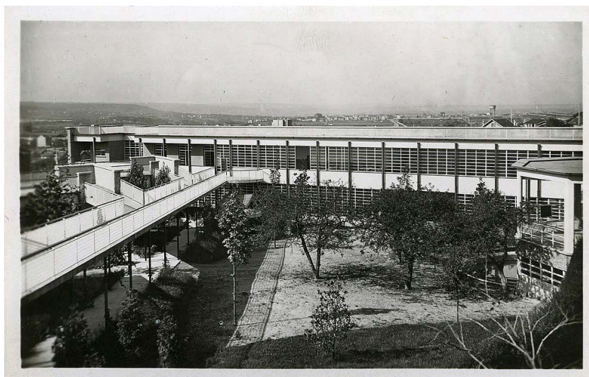
Fig. 56 photo passerelles, école de plein air de Suresnes, E. Beaudouin et M. Lods
