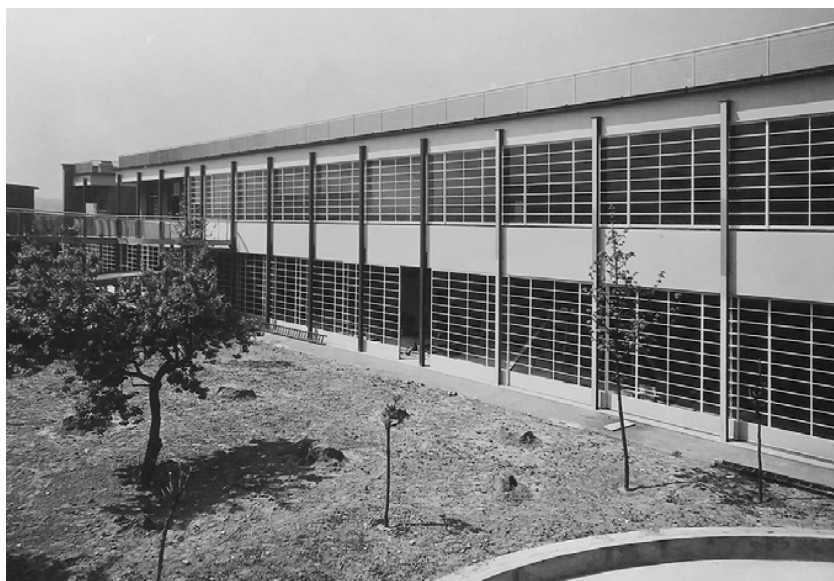
Fig. 51 Façade côté parc, école de plein air de Suresnes, E. Beaudouin et M. Lods
