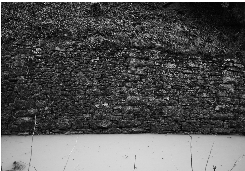
Vestiges du canal d'Entreroches. Mur de soutènement Photographie de l'auteur, janvier 2018.
