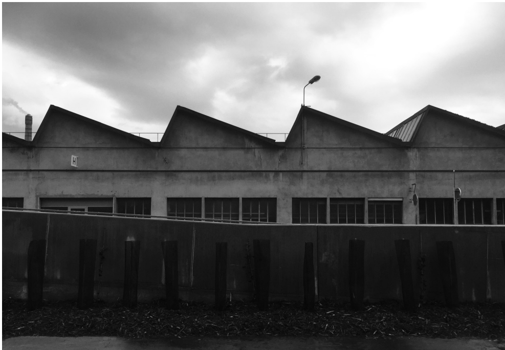
Penthalaz, Halle industrielle des anciennes Câbleries. Photographie de l'auteur, décembre 2017.
