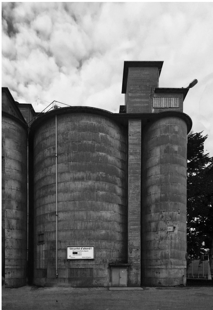
Eclépens. Silo à la cimenterie Holcim. Photographie de l'auteur, novembre 2017.
