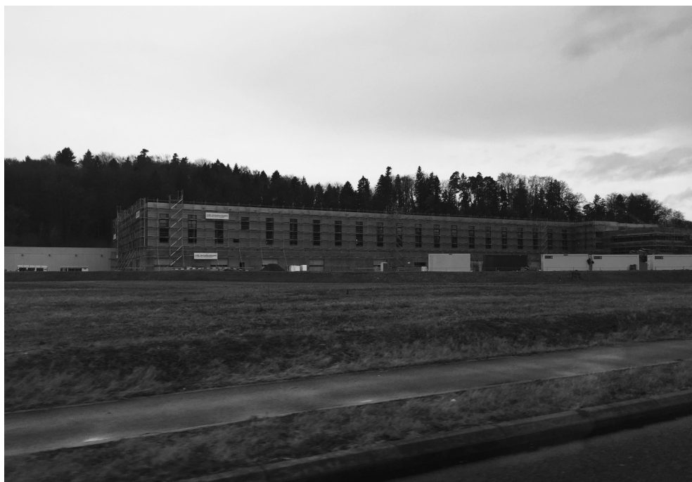
Zone industrielle de la Plaine d'Acles. Halle logistique en construction. Photographie de l'auteur, janvier 2018.
