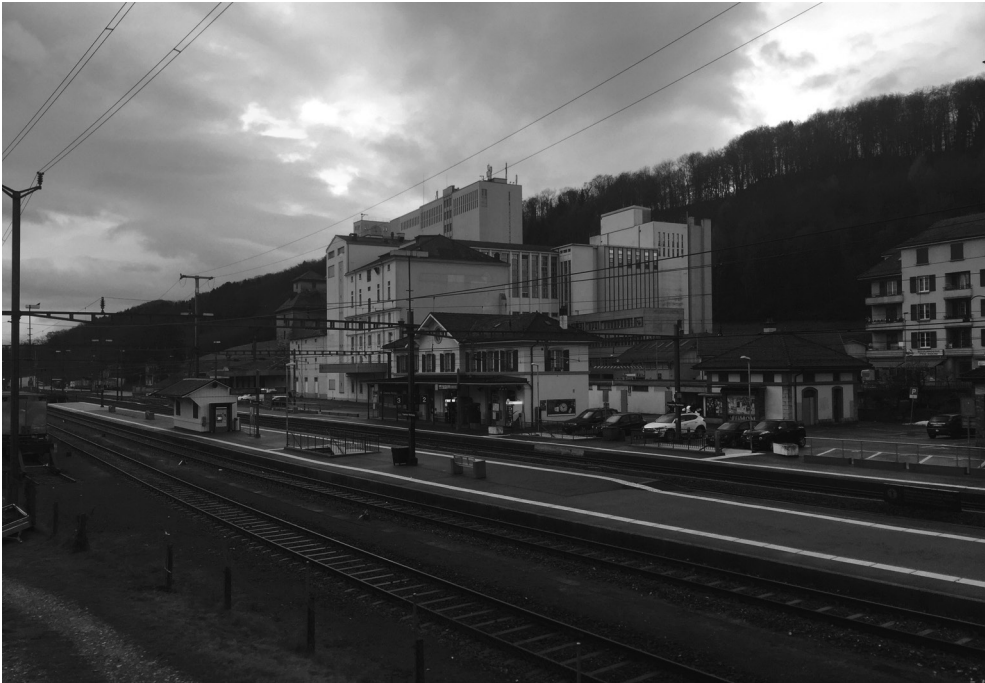
Penthalaz, Les Grands Moulins et la gare. Photographie de l'auteur, décembre 2017.
