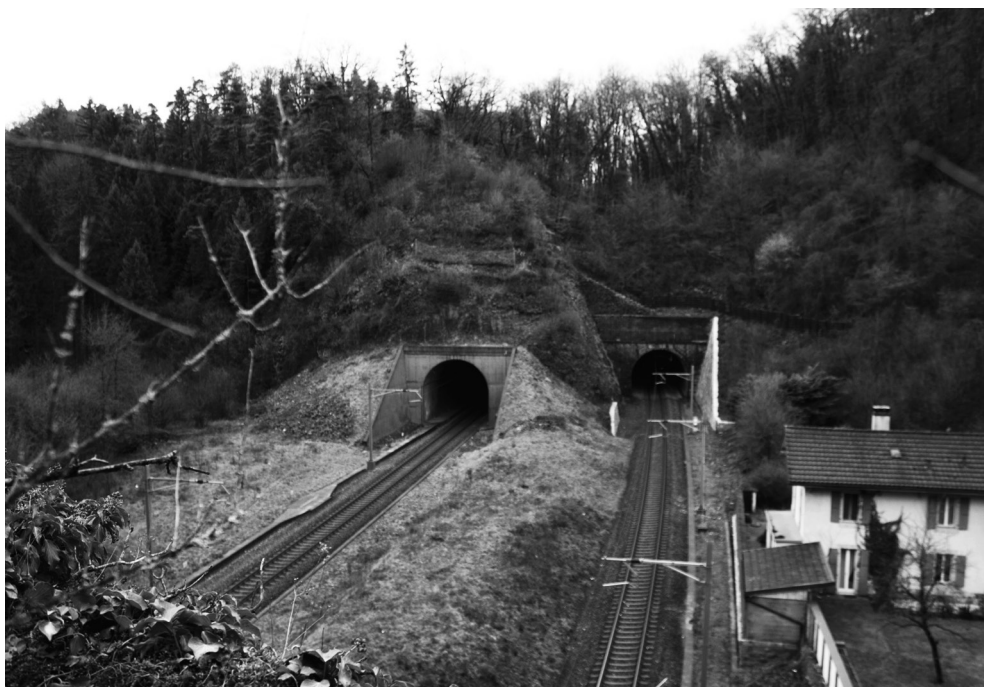
Tunnels ferroviaires dans la faille d'Entreroches. Photographie de l'auteur, janvier 2018.
