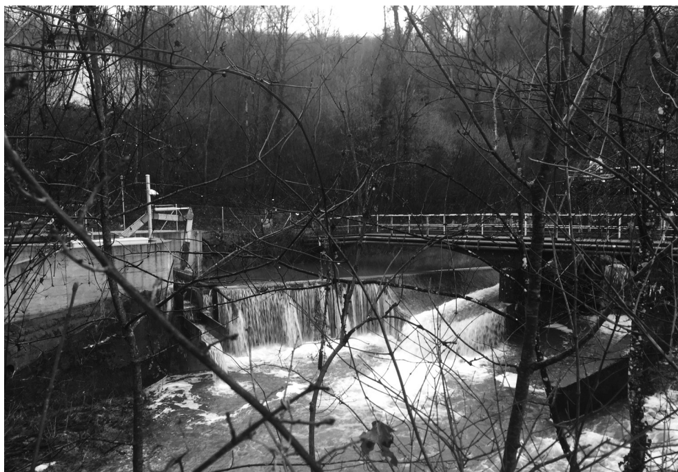
Penthalaz, Installation hydroélectrique sur la Venoge. Photographie de l'auteur, décembre 2017.
