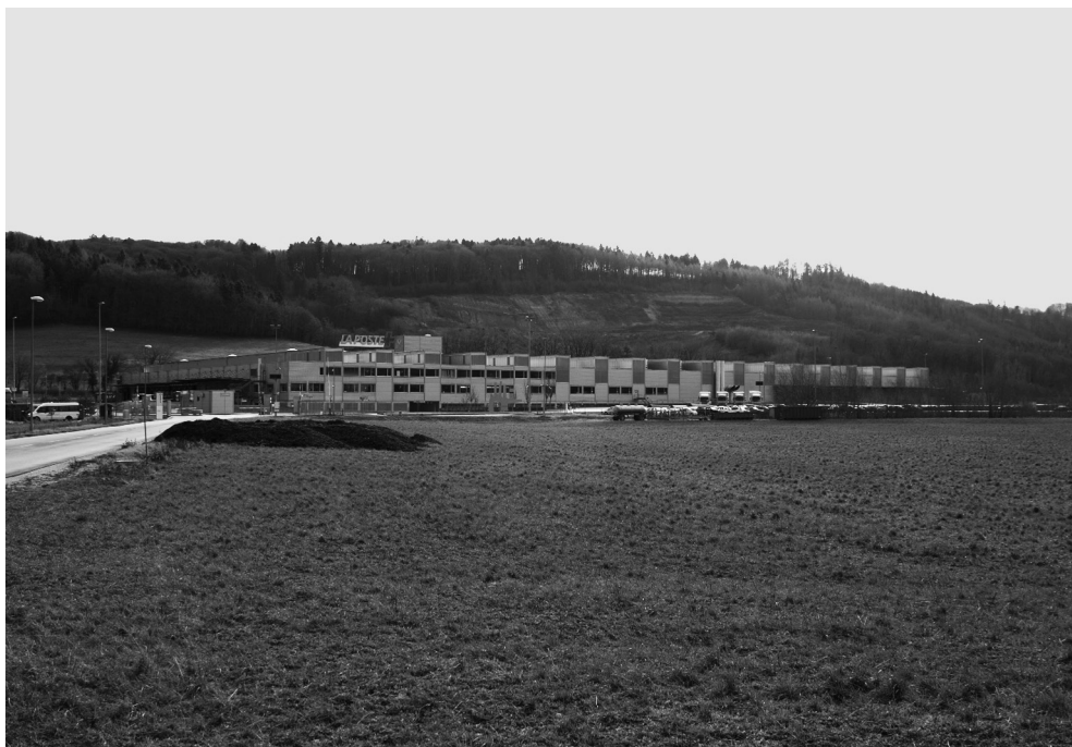
Eclépens. Le centre de tri du courrier de La Poste. Photographie de l'auteur, janvier 2018.
