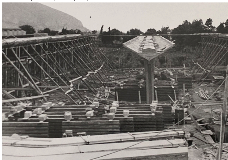
Figura 26 - Il getto in opera delle travi e delle capriate a piè d'opera, FMZ - AdM
