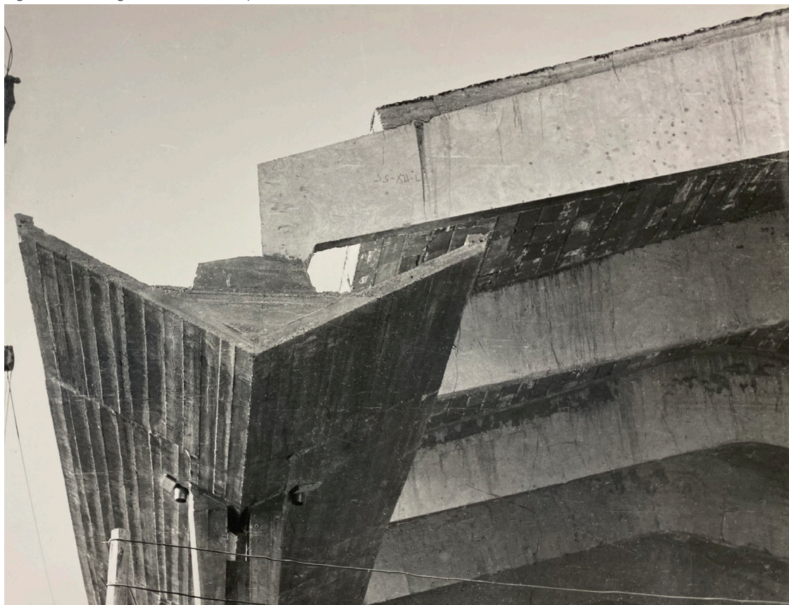
Figura 28 - Dettaglio del raccordo capriate-trave, Cantiere, FMZ -AdM
