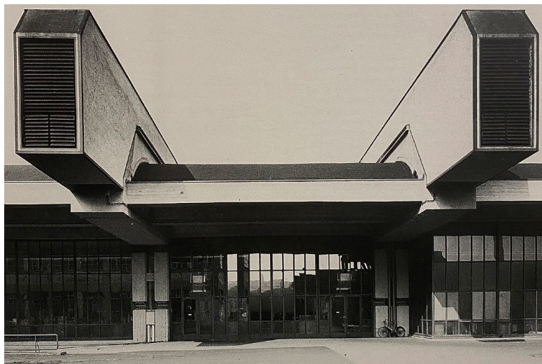
figura 13 - Stabilimento Necchi, cantiere
