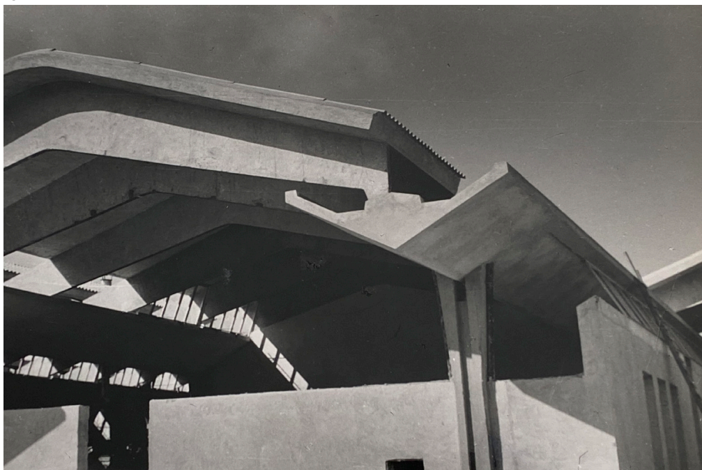
figura 18 - Il sistema Trave-Pilastro, cantiere, FMZ - AdM
