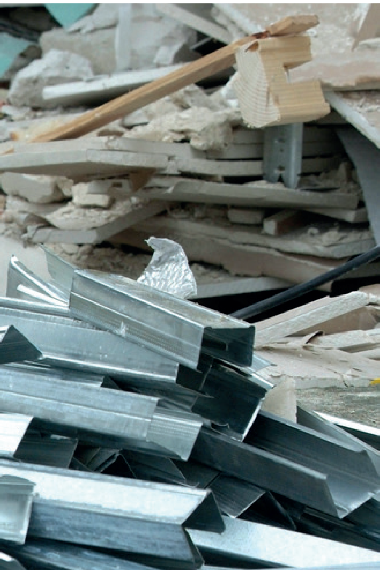
Image d'illustration d'une démolition classique
