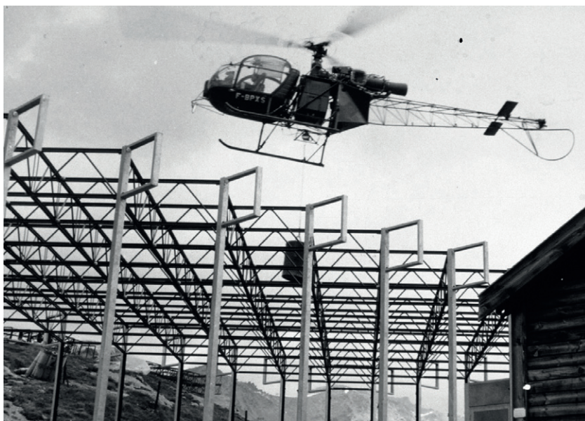
Fig. 32 Assemblage de la charpente
