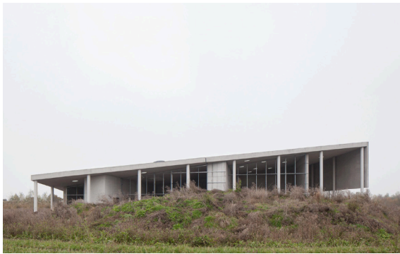
Le Crématorium, OFFICE KGDVS, photographie Bas Princen
