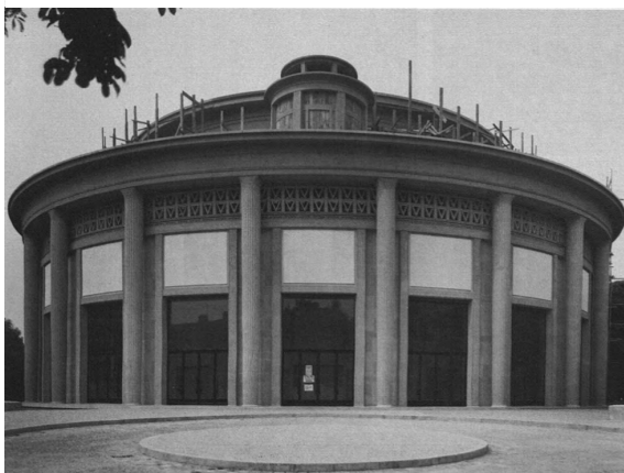
Perret Auguste, Musée des Travaux Publics, construction de la rotonde
