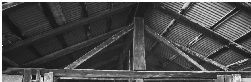
Charpente - Grange-écurie n°52
