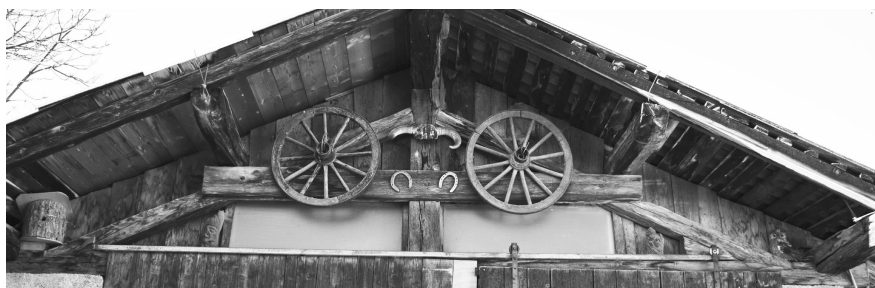
Charpente - Grange-écurie n°51
