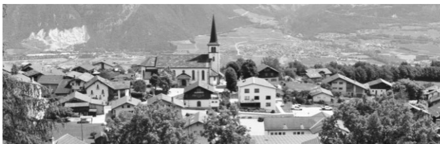
Vue après la construction de la maison de commune
