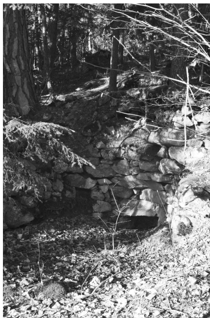
Un ancien four à chaux , vue de dessus (gauche) et de l'avant (droite)
