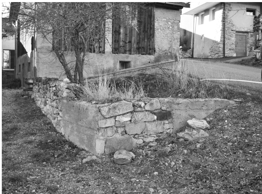
Anciennes fondations visibles d'une grange-écurie démolie
