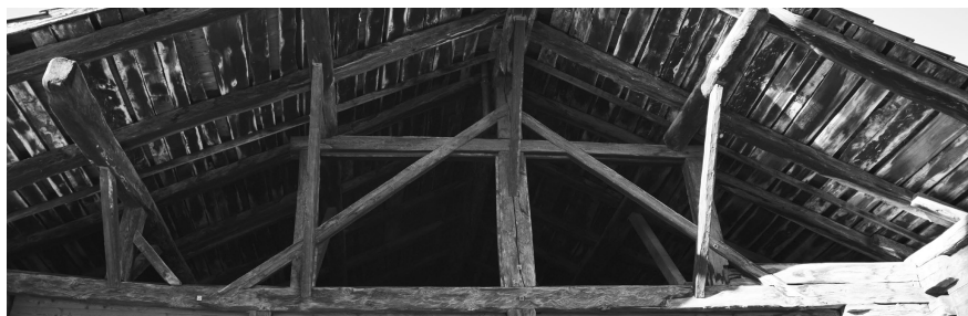
Charpente - Grange-écurie n°33
