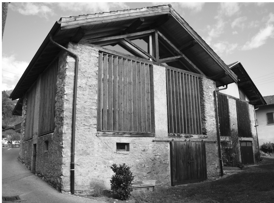
«La première»; transformation d'une grange-écurie au centre du village, façade Sud
