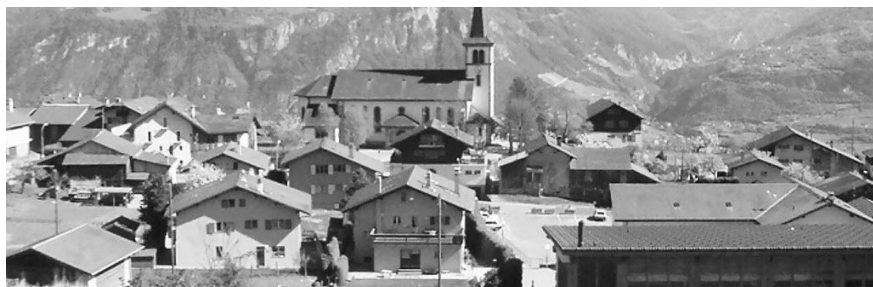
Vue avant la démolition de la grange-écurie et de la maison attenante
