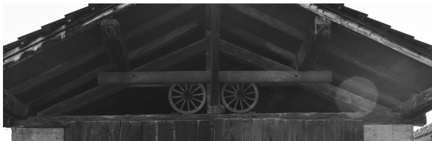
Charpente - Grange-écurie n°3
