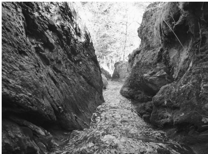
Le bisse de bitaillaz, tronçon creusé dans la roche
