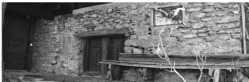
Porte d'écurie - Grange-écurie rénovée
