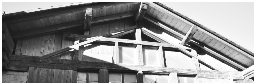
Charpente - Grange-écurie n°13
