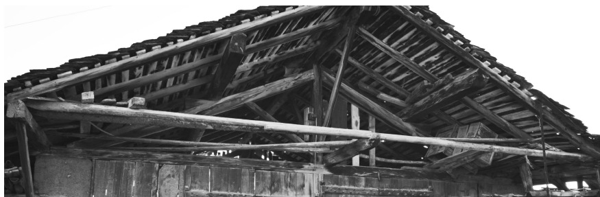
Charpente - Grange-écurie n°44
