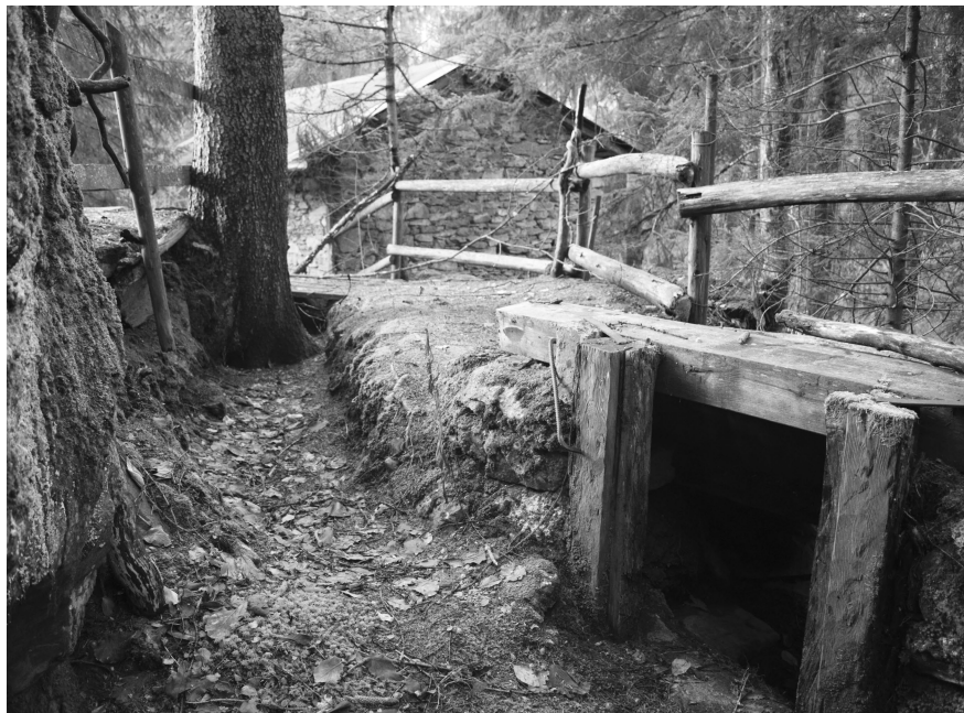
Aménagements pour amener l'eau jusqu'au moulin
