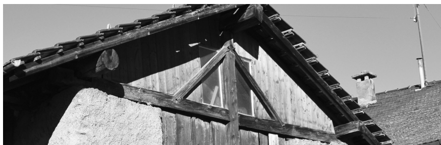
Charpente - Grange-écurie n°34
