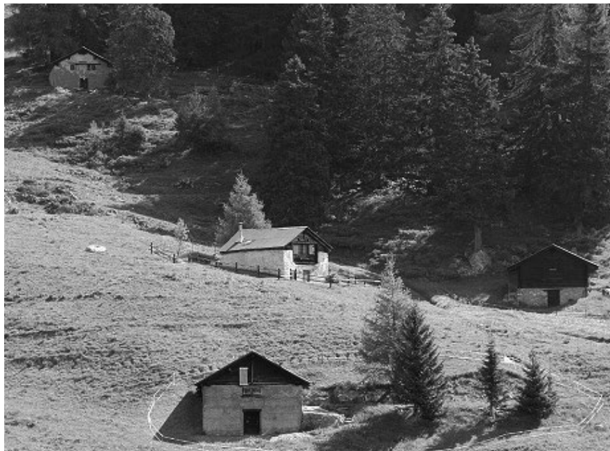
Les mayens dans la combe d'Arbaz
