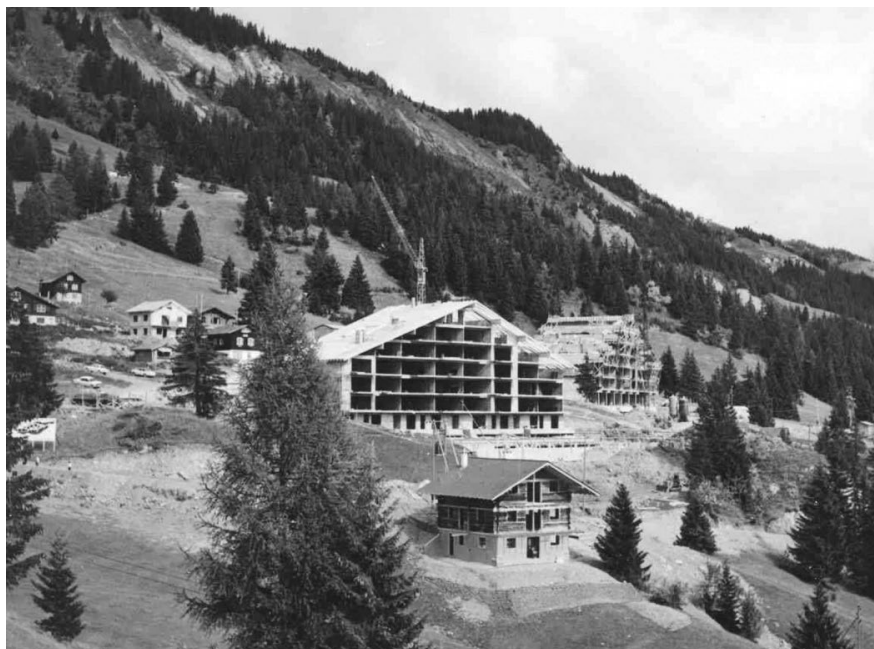
Construction des premiers immeubles de la station d'Anzère, env.1960
