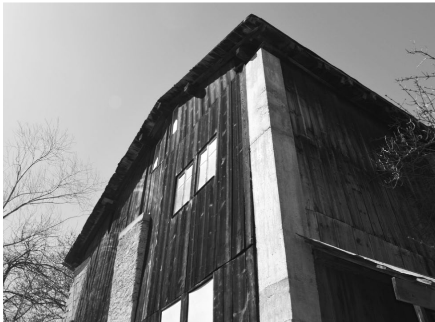
Dernier agrandissement; pilier en béton sur toute la hauteur, façade Sud et Est
