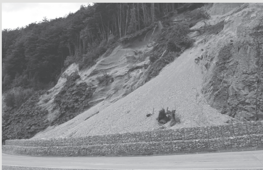
Mur en Gabions à Villa Amengual
