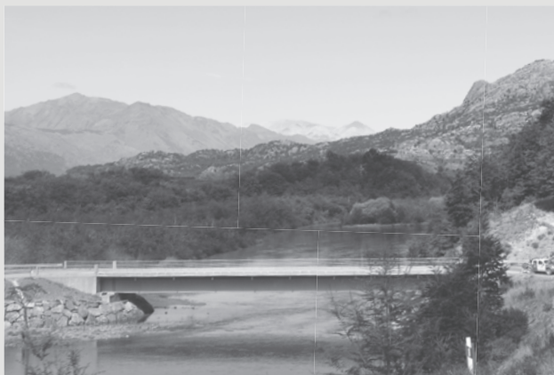
Pont métallique à Villa O'Higgins
