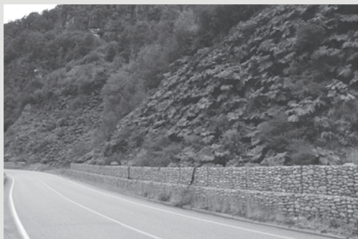
Mur en Gabions à Piedra del gato
