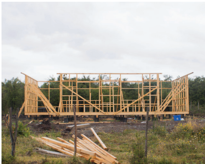
Construction proche de Aulén
