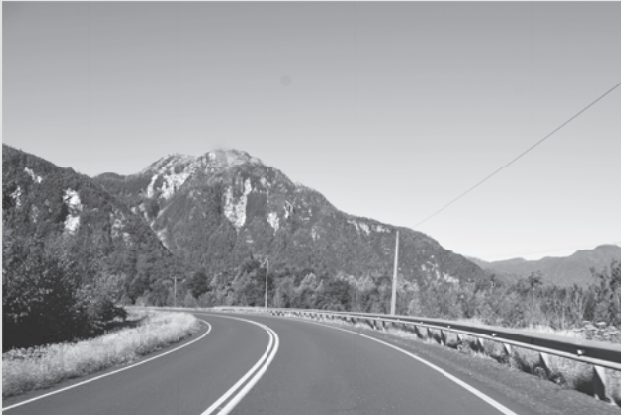
Route asphaltée près de Chaitén
