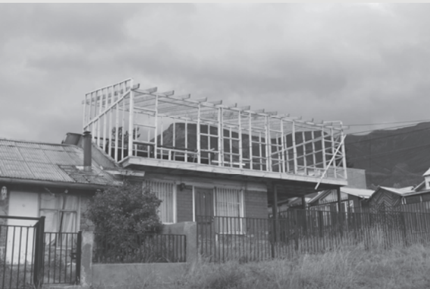
Extension d'une maison à Coyhaique
