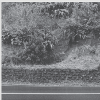
Mur Pierre-Béton à Lenca
