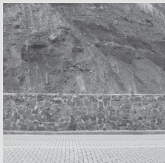
Mur Pierre-Béton à Coyhaique
