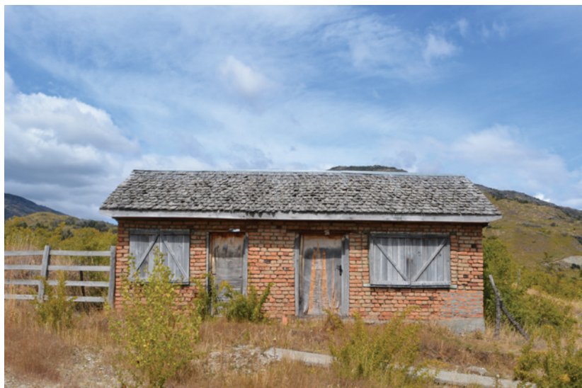
Maison en briques à Puerto Guadal
