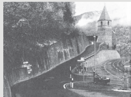
Exemple de forme incorrecte ©Marnes Vol.4
