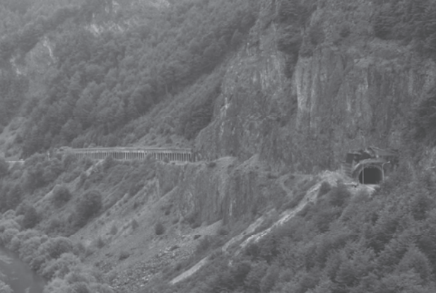
Tunnel proche de Coyhaique
