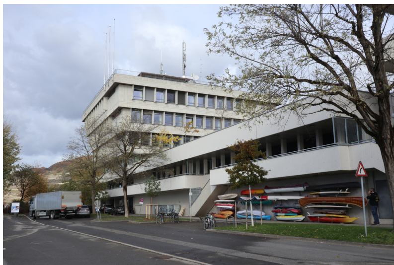
Figure 33. Vue depuis la promenade du lac (il n'est pas possible de devi- ner que la STEP existe derrière)
