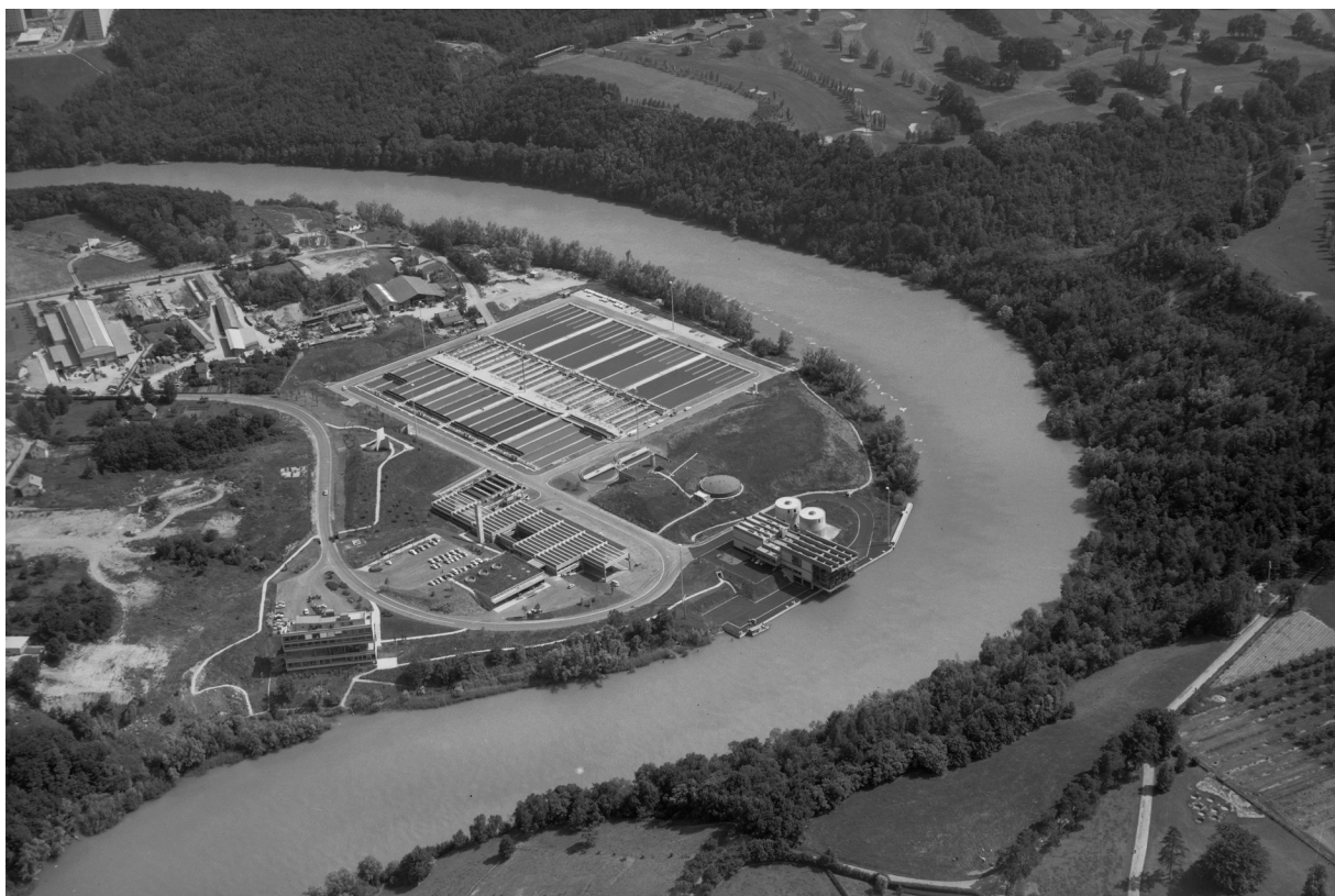
Figure 69. Vue d'ensemble de la STEP d'Aire
