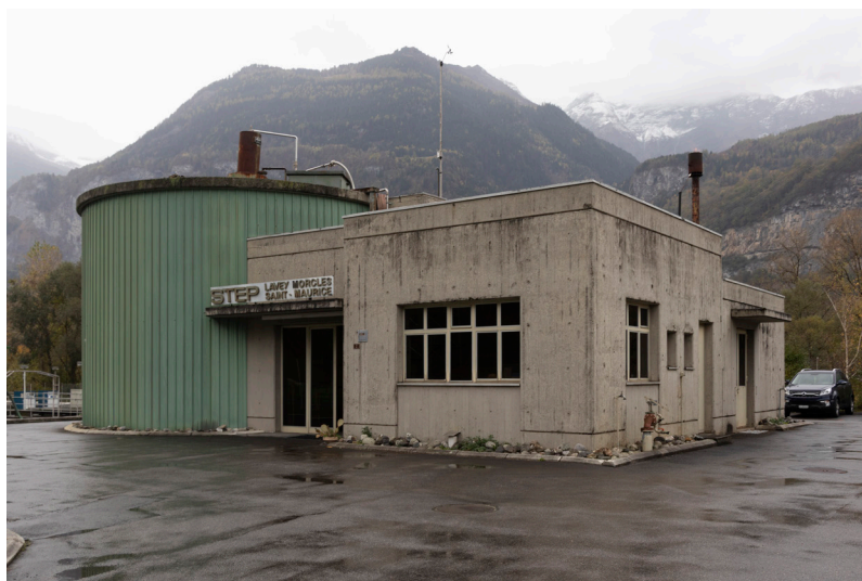
Figure 29. Bâtiment principal administratif (en béton armé brut de décoffrage) et le digesteur (avec revêtement en tôle métallique)
