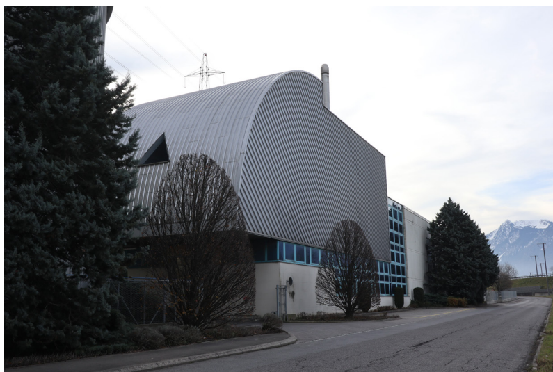
Figure 55. Bâtiment du traitement et stoc- kage des huiles (avec la partie supérieure recouverte en tôle métallique construite lors de la deuxième étape)
