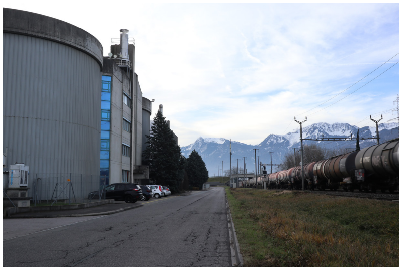
Figure 52. Passages fréquents et très proches des trains (passagers et marchandises) en face de la STEP
