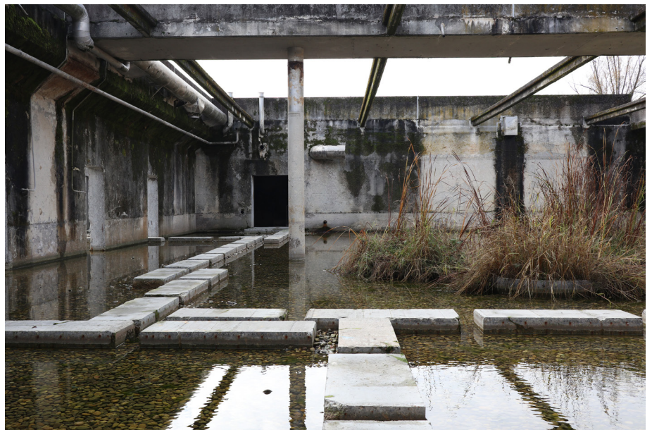
Figure 64. Jardin d'eau avec une prome- nade créée avec des dallettes en béton
