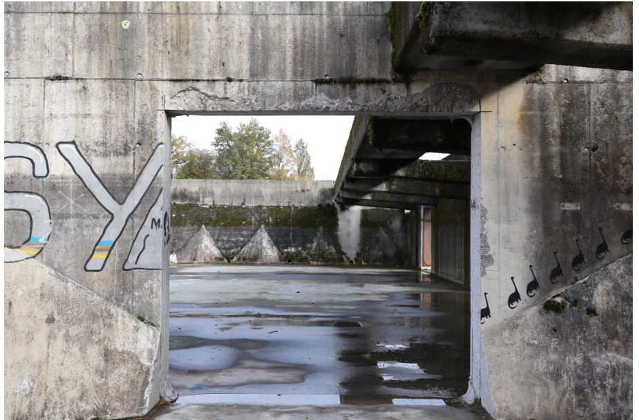
Figure 65. Percement « chirurgical » dans un bassin à un endroit précis
