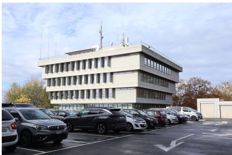
Figure 36. Terrasse parking au-dessus de la STEP
