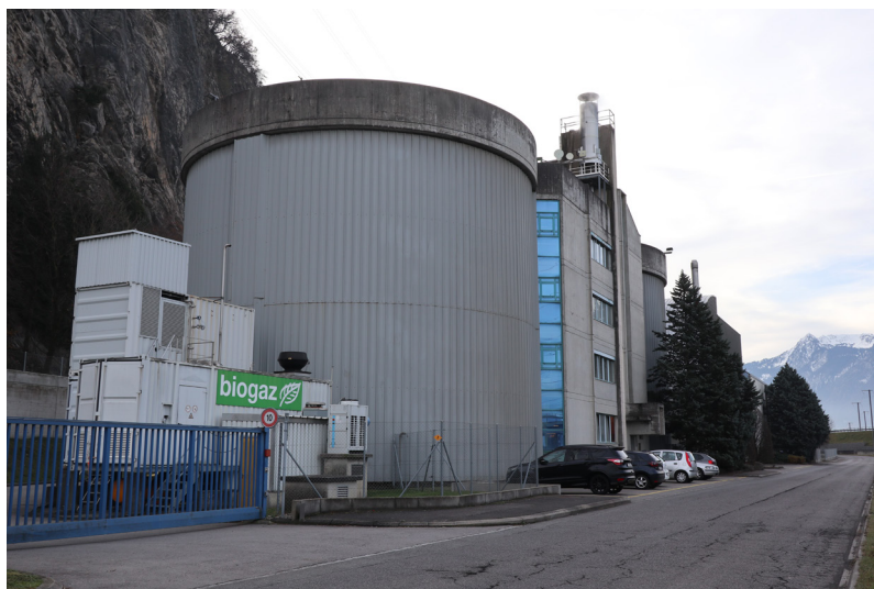
Figure 54. Bâtiment de l'administration et de digestion des boues
