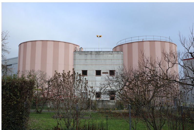
Figure 50. Digesteurs donnant sur un jardin privé appartenant à une maison individuelle avoisinante
