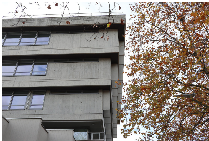
Figure 35. Bâtiment administratif prenant de l'ampleur à chaque étage supérieur
