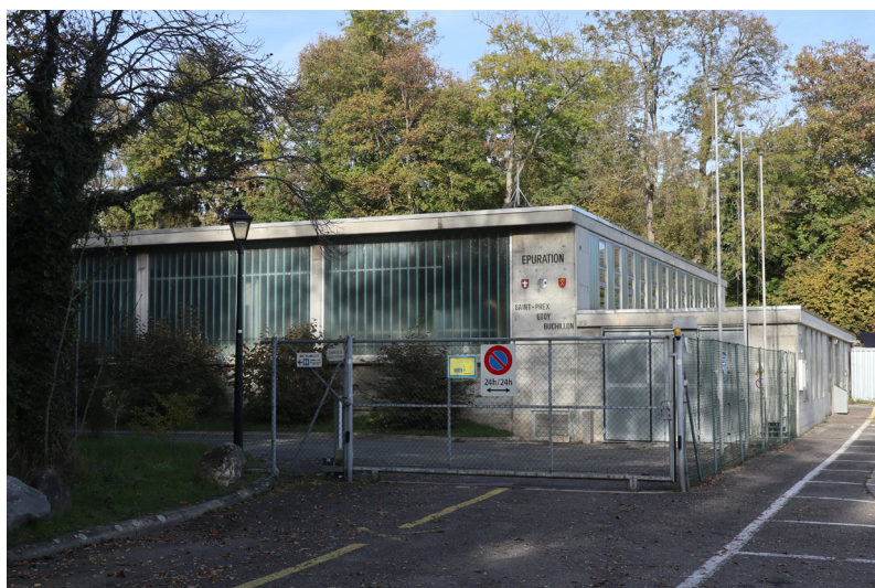
Figure 21. Entrée sécurisée et façade Ouest
