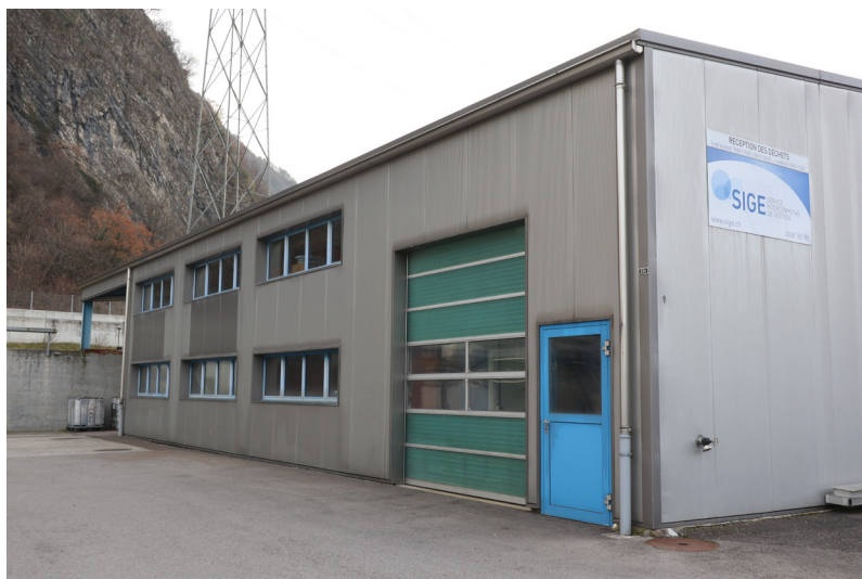
Figure 57. Bâtiment de la réception des déchets construit en deuxième étape
