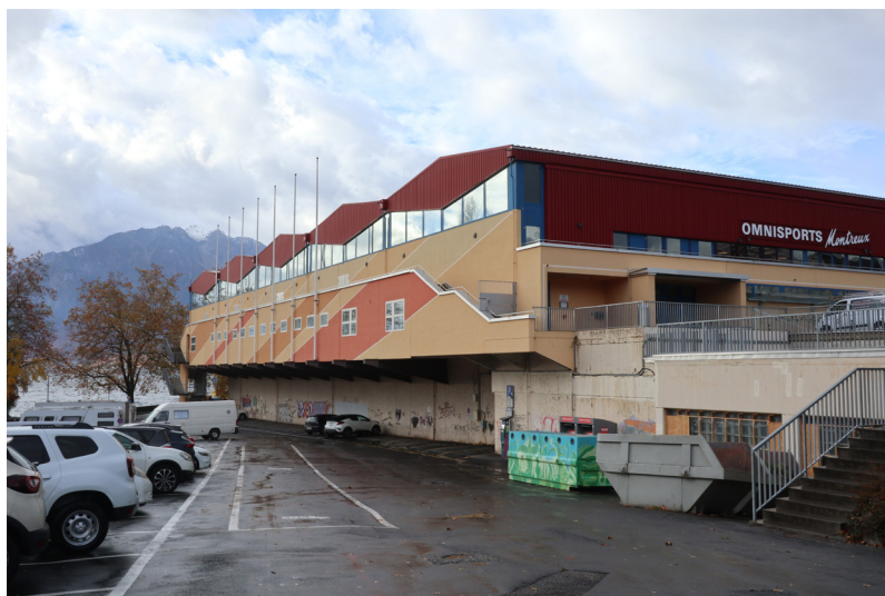
Figure 41. Volume de la salle Omnisports presque oppressant au-dessus de la STEP
