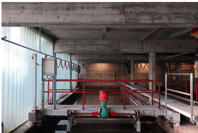
Figure 22. Structure poteau-poutre en béton armé brut de décoffrage et enveloppe semi-transparente
