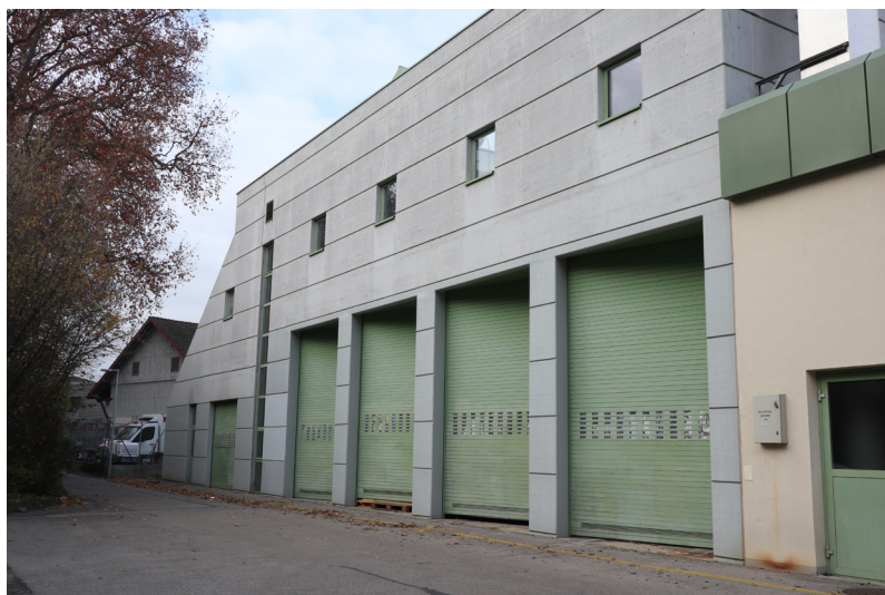
Figure 49. Grandes portes donnant sur l'espace de traitement et de stockage des boues
