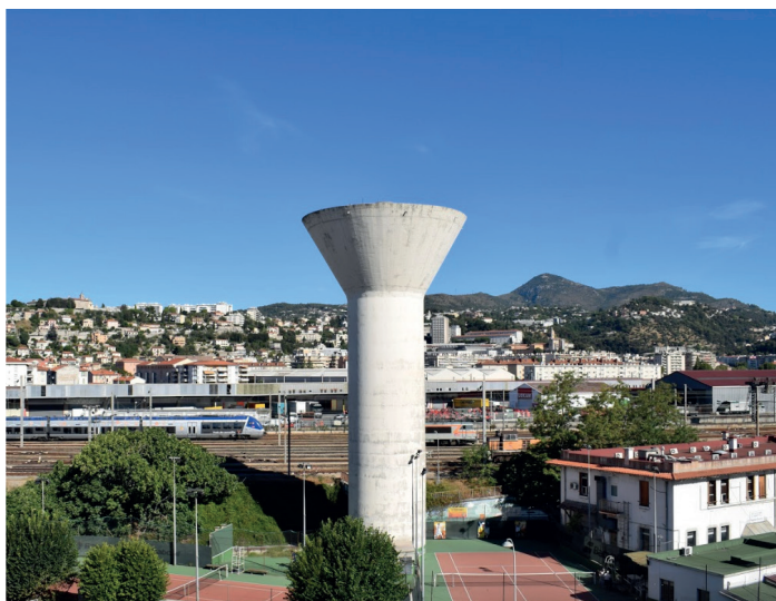
La gare de marchandises Saint-Roch vue depuis le sud-est aujourd'hui
