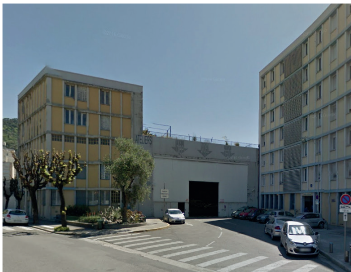
La façade Nord et l'entrée de la halle Spada aujourd'hui
