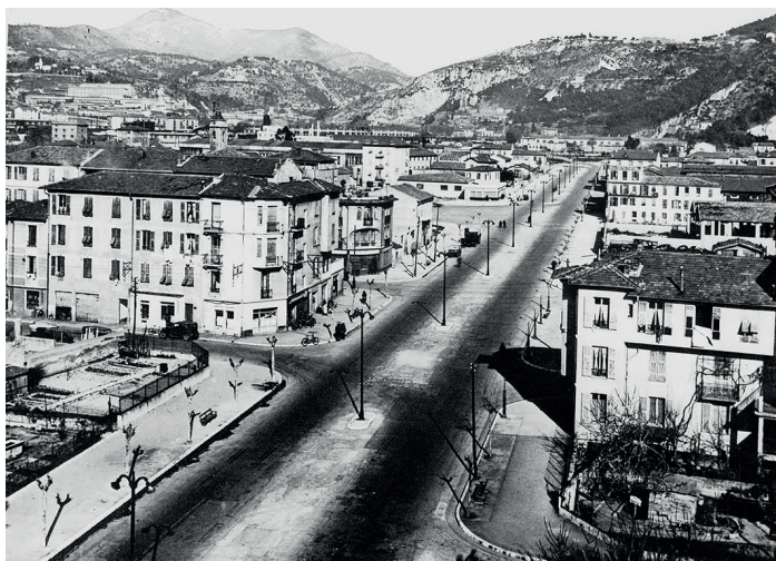
Construction du boulevard Saint-Roch en 1936. C'est le principal axe de communication qui traverse le quartier du nord au sud. Collection Sourgentin
