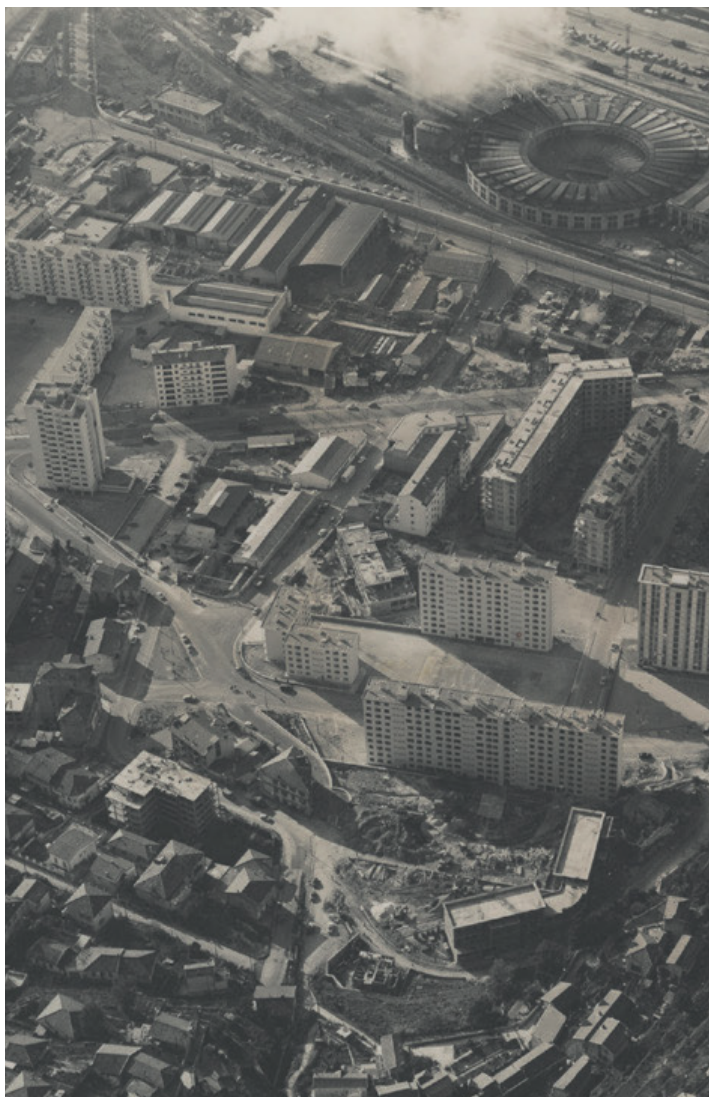
Vue aérienne des nouvelles constructions, 1961 Fonds du service photographique des Archives municipales de Nice
