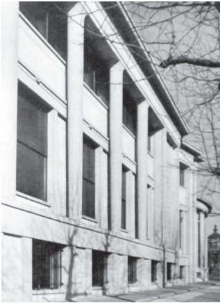
Musée des Travaux publics, Paris, 1936 -1948. Façade sur l'avenue d'Iéna. Ci-dessous, façade de la rotonde sur la place d'Iéna.
