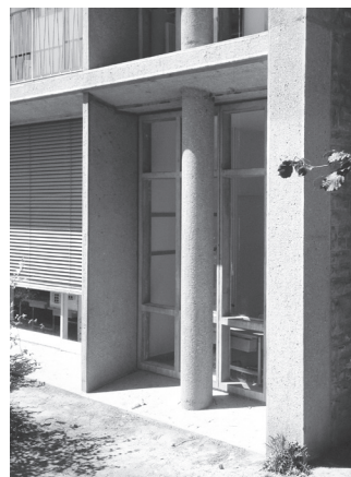
Les piliers de la façade sud-est sont coupés par la dalle intermédiaire saillante. Les minces cloisons intérieures ressortent en façade, interférant avec le rythme des piliers.
