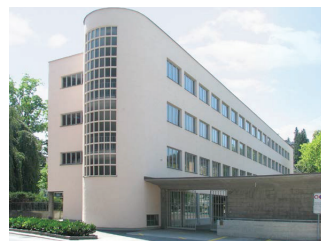
Page de gauche, ci-dessus, façade du complexe scolaire depuis la Bruchstrasse. Ci-dessous, comparaison de la façade sud des années 1930 et après sa rénovation en 2005.
