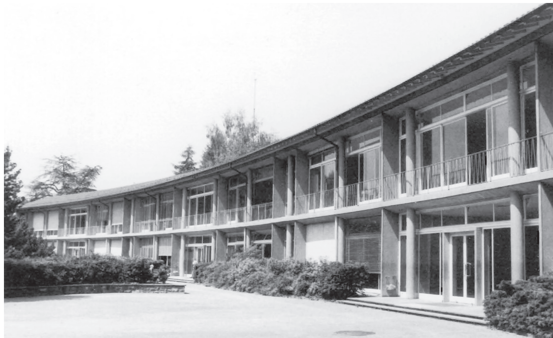
Les piliers de la façade sud-est sont coupés par la dalle intermédiaire saillante. Les minces cloisons intérieures ressortent en façade, interférant avec le rythme des piliers.
