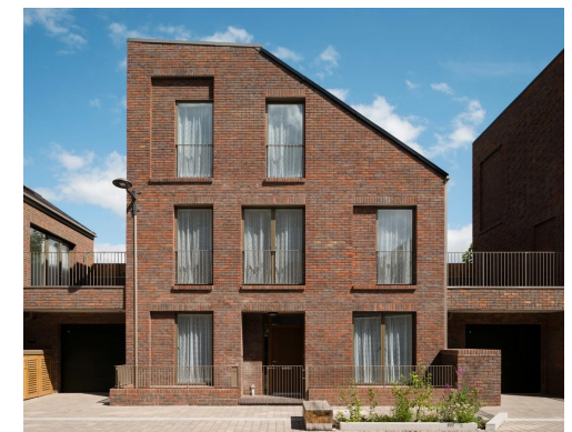
24. Articulation des façades et espaces extérieurs (type 3) Photographie : Karakusevic Carson architects
