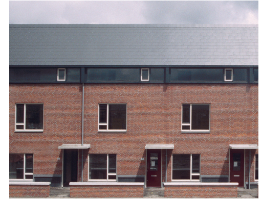
16. La régularité typologique visible en façade Photographie : Hans Van Der Heijden Architecten
