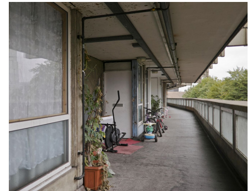
11. Coursive desservant l'ensemble des logements de l'étage Photographie : http://kvadratinterwoven.com © Photo Anthony Palmer
