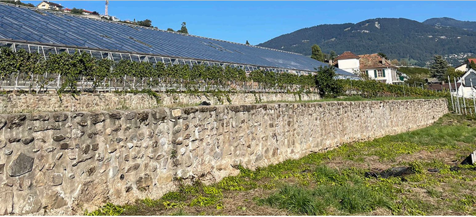
Vue extérieur sur les serres et les murs, créant une linéarité
