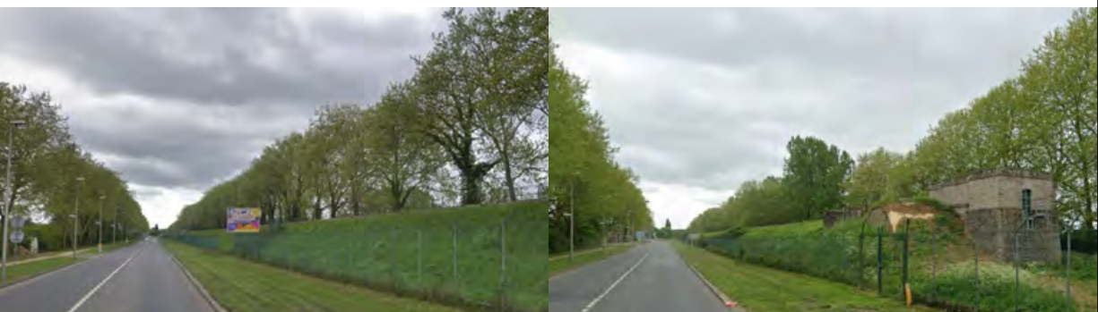
Vue sur l'aqueduc depuis la route
