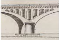
Fig. 10. Ci-dessus, arcades du siphon de l'Yonne avec contreforts latéraux pour lutter contre le courant
