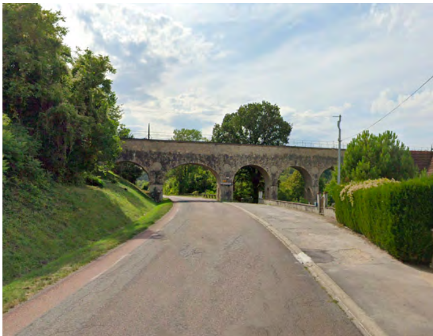
Vue sur l'aqueduc comme porte depuis la ville au sud-ouest
