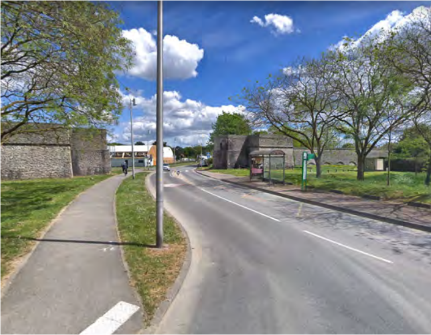
Vue sur les siphons
