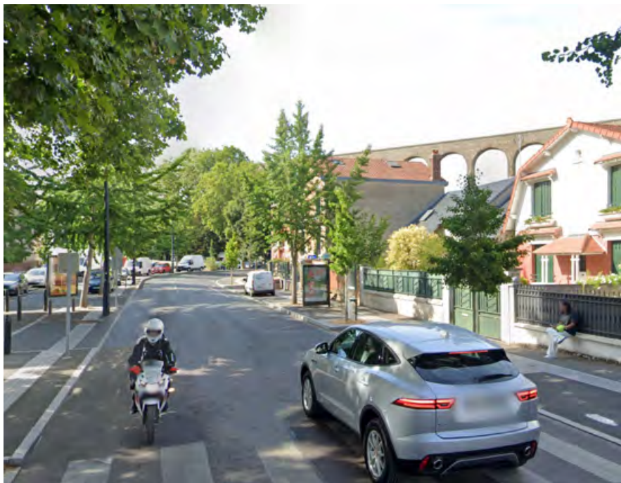
Vue sud-est sur l'aqueduc depuis Cachan
