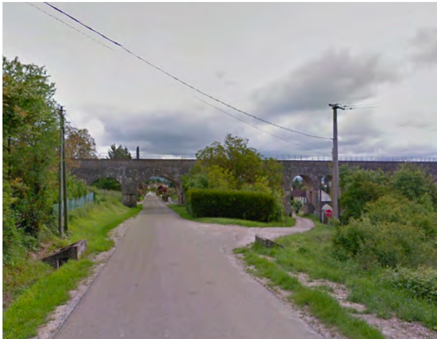
Vue sur l'aqueduc comme porte hors de la ville au nord-ouest
