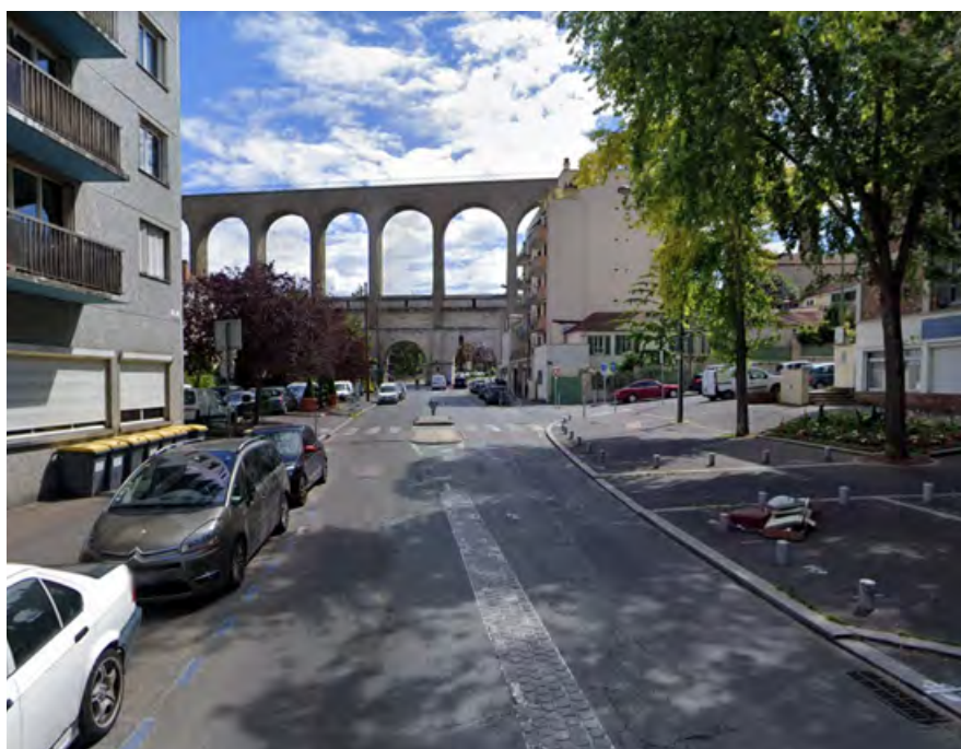
Vue nord-ouest sur l'aqueduc depuis Arcueil
