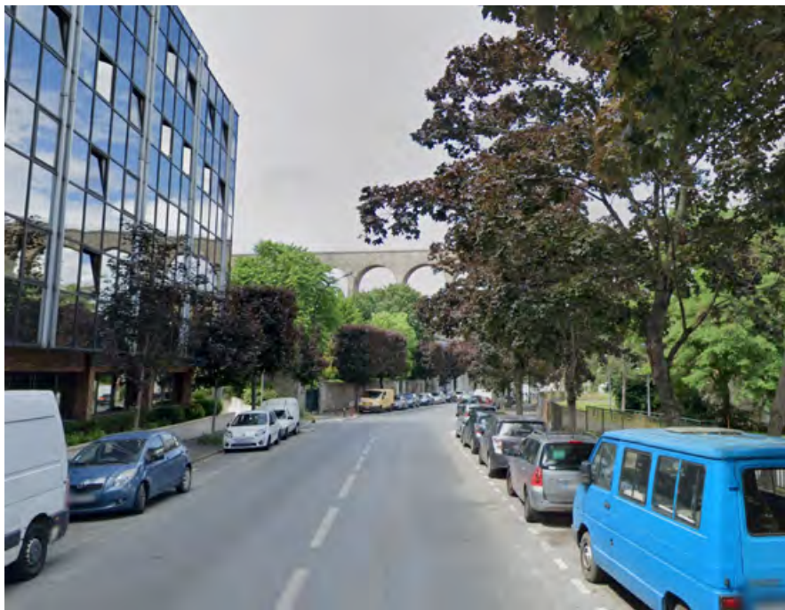
Vue sud-ouest sur l'aqueduc depuis Cachan
