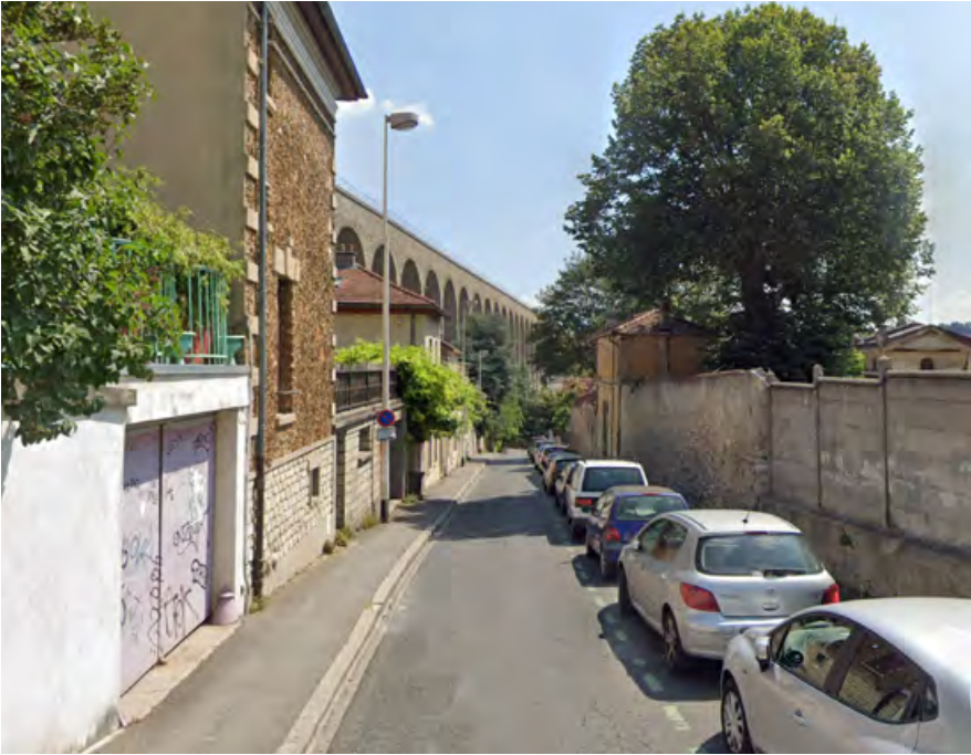
Vue ouest sur l'aqueduc depuis Cachan
