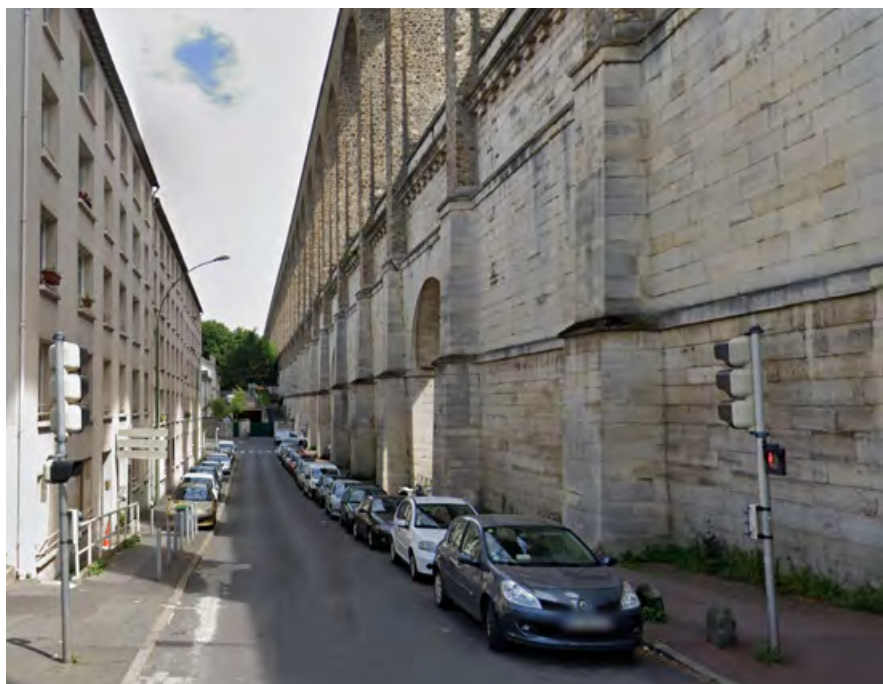
Vue sur l'aqueduc depuis Arcueil dans le creux de la vallée
