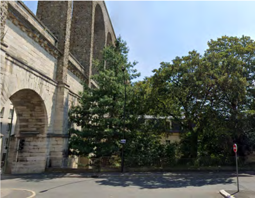
Vue ouest sur l'aqueduc et l'entrée de Cachan
