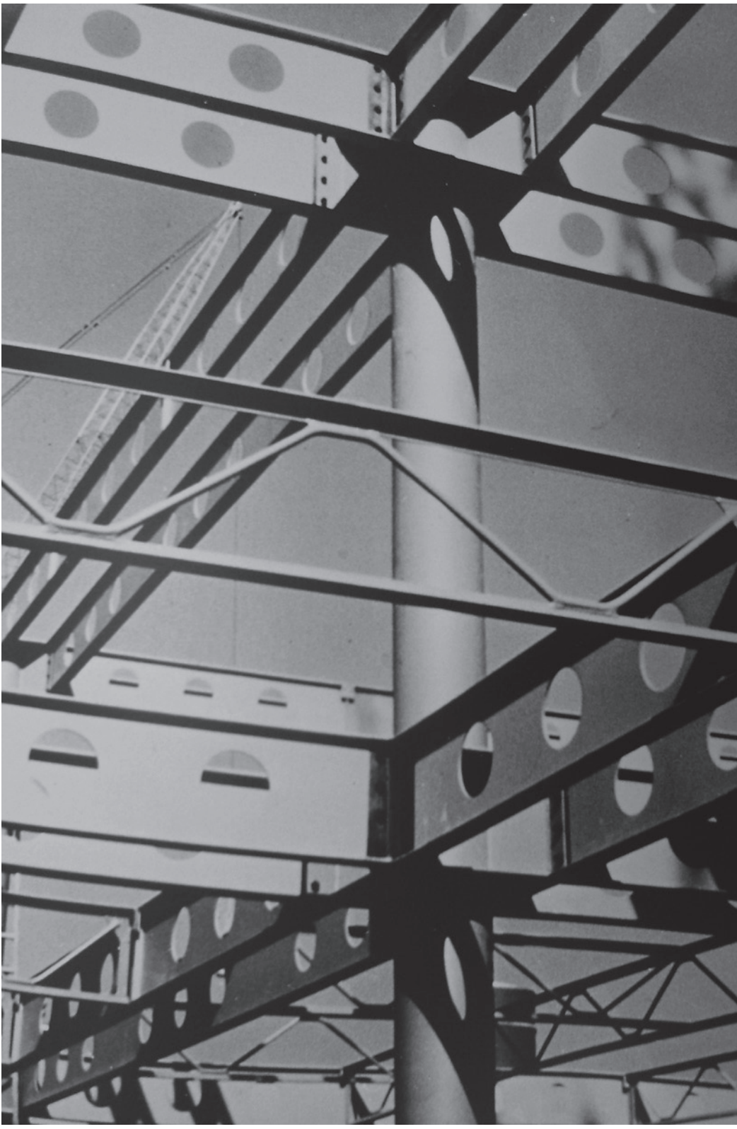
Système C.R.O.C.S. en cours de montage
