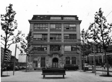
Fig. 10 : L'Usine, vue depuis la place des Volontaires
