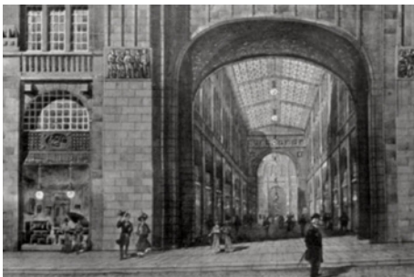
Fig. 57 : Façade des Tacheles
