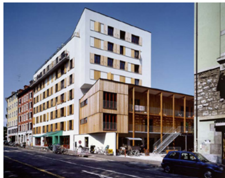
Fig. 121 : Vue de l'Ilôt 13 restructuré, Atelier Oleg Calame architecte EPFL, FAS, SIA
