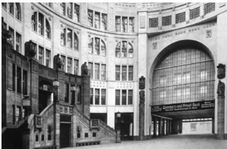
Fig. 58 : Façade des Tacheles
