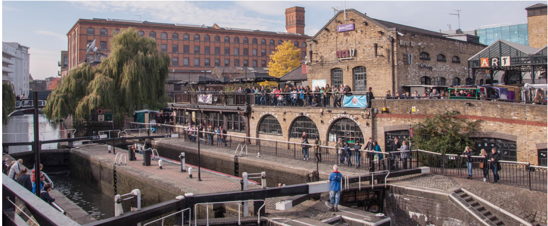
Fig. 31 : Le Dingwall (bâtiment au centre)
