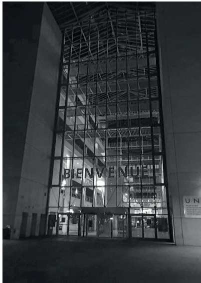
Figure 5. Photo de l'entrée du bâtiment de l'Uni Mail à Genève
