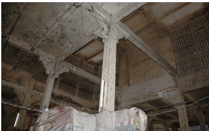
rez-de-chaussée du marché
