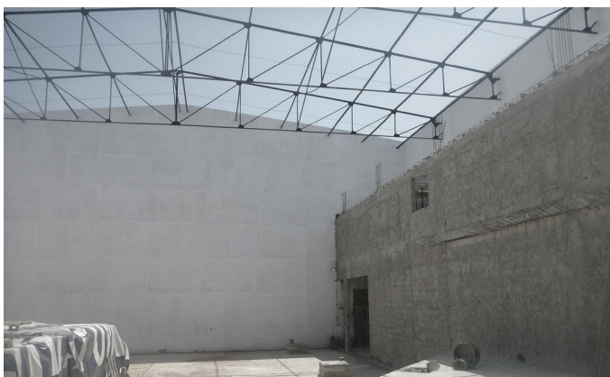
charpente métallique restaurée
