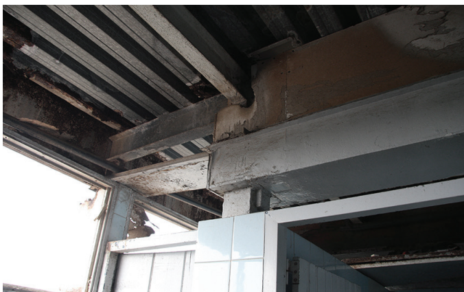
pavillon F faux-plafond d'un bloc sanitaires
