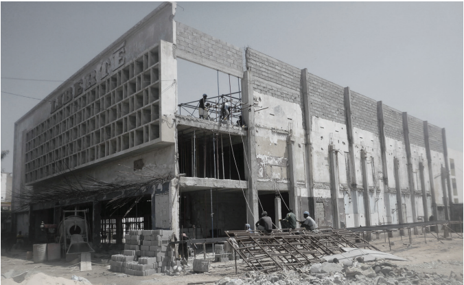
rénovation en cours
