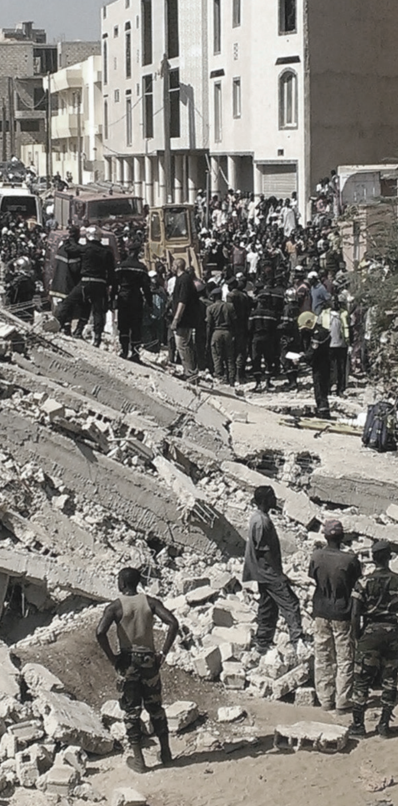
Effondrement d'un immeuble, Ouakam. 08/03/2013
