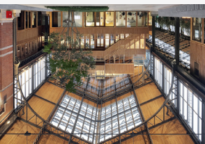
Gare Maritime Neutellings Riedijk Architects Bruxelles (Belgique) construction: 1907 transformation: 2018 - 2020
