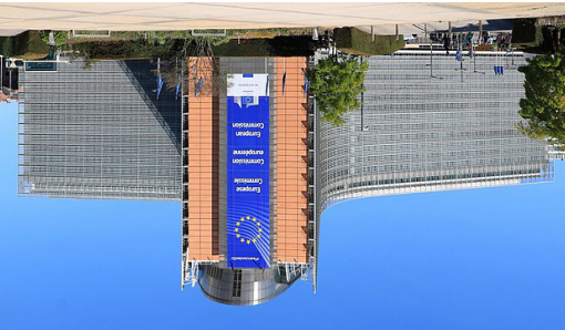
Bâtiment Berlaymont Société Berlaymont 2000 Bruxelles (Belgique) transformation: 1995-1999
