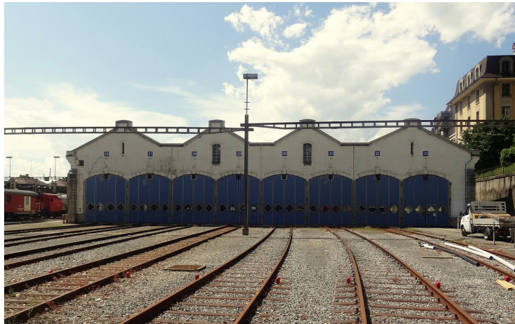
Fig. 14 – Halles aux Locomotives CFF avant leurs destructions. (© Photo de Sylvie Bazzanella, 2013)
