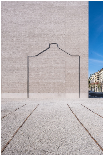
Fig. 15 – Facade du nouveau bâtiment MCBA, rappel formel des Halles. (© Photo de Dominik Gehl)
