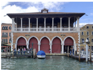
Fig. 61 Façade sur le canal de la Loggia del Pesce.
