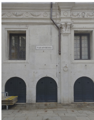
Fig. 41 Détail des anciennes ouvertures des cellules des prisons.
