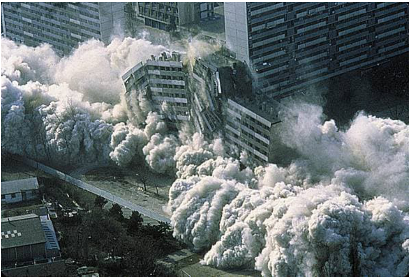
Fig. 4: Démolition d'un immeuble d'habitation à d'une manière "upside-down".
